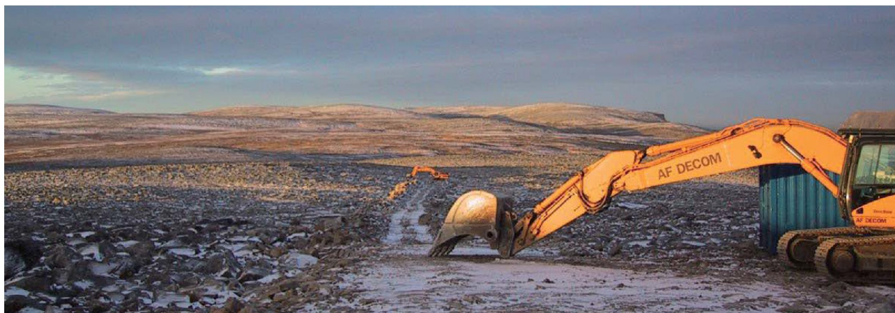
Figur 7 Kjøring med maskiner skal holdes så nær veilinja som mulig slik at ikke vegetasjon som lyng og lav tar unødvendig skade og steinmassene blir unødvendig rørt ved. Fra Kjøllefjord vindpark. Foto: Svein-Rune Wian (Fra designmanual Raggio I)
