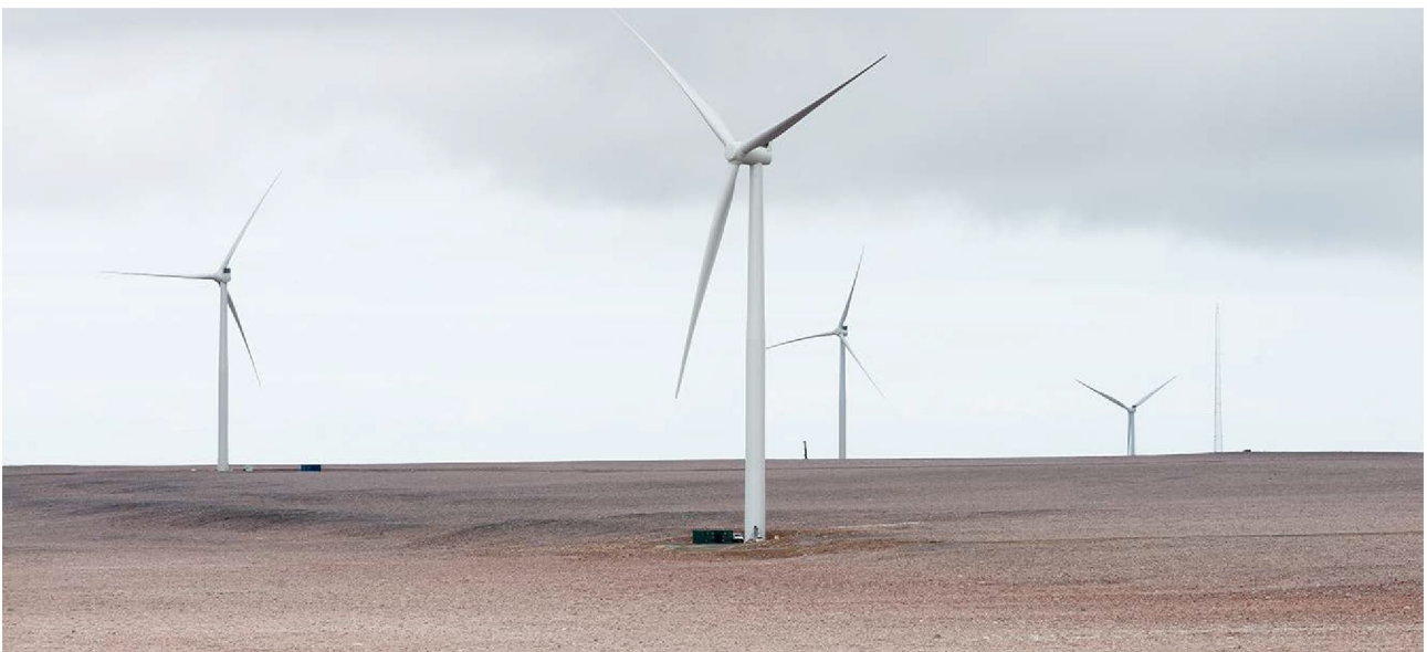
Figur 5 Bildet viser første utbyggingstrinn ved ferdigstilling der inngrepene er vel integrert i landskapsbildet
