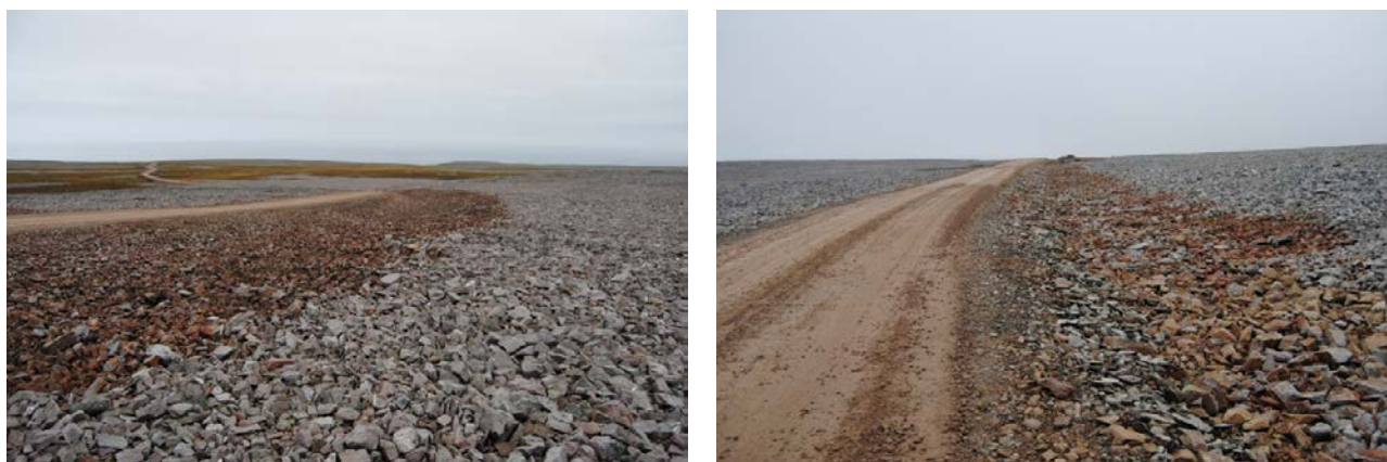
Figur 11 Venstre bilde: Området langs veien ferdig arrondert uten innblanding av grå stein. Det brune partiet blir markert. Høyre bilde: Blanding av grå og brun stein gjør overgangen mykere
