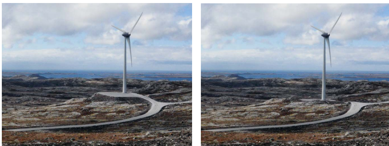
Figur 19. Minst mulig eksponering av kranoppstillingsplass og fundament er viktig for god landskapstilpassing, her vist ved senking av oppstillingsplass slik at utstrakte fyllinger unngås og gjenstående knauser delvis skjermes for innsyn.
