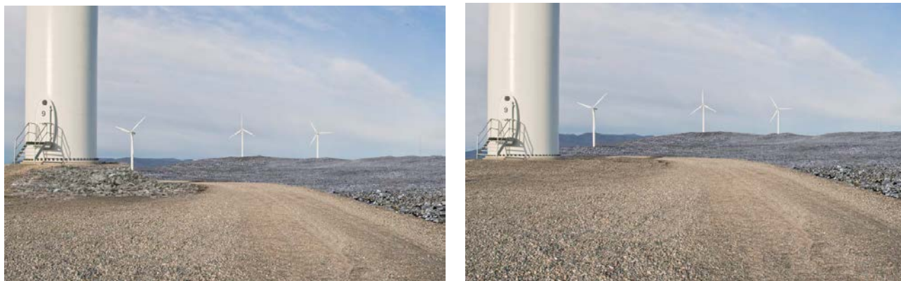
Figur 18 Et fundament som ligger hevet eller senket i forhold til turbinoppstillingsplassen vil oppleves som dårlig forankret til landskapet
