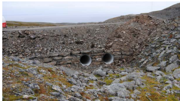
Figur 16 Begge situasjonene mangler litt i forhold til ferdigstilling / finish. På situasjonen til venstre burde steinene legges noe ryddigere mens steinsettingen med fordel kunne blitt dratt noe høyere på situasjonen til høyre.
