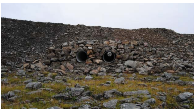
Figur 16 Begge situasjonene mangler litt i forhold til ferdigstilling / finish. På situasjonen til venstre burde steinene legges noe ryddigere mens steinsettingen med fordel kunne blitt dratt noe høyere på situasjonen til høyre.
