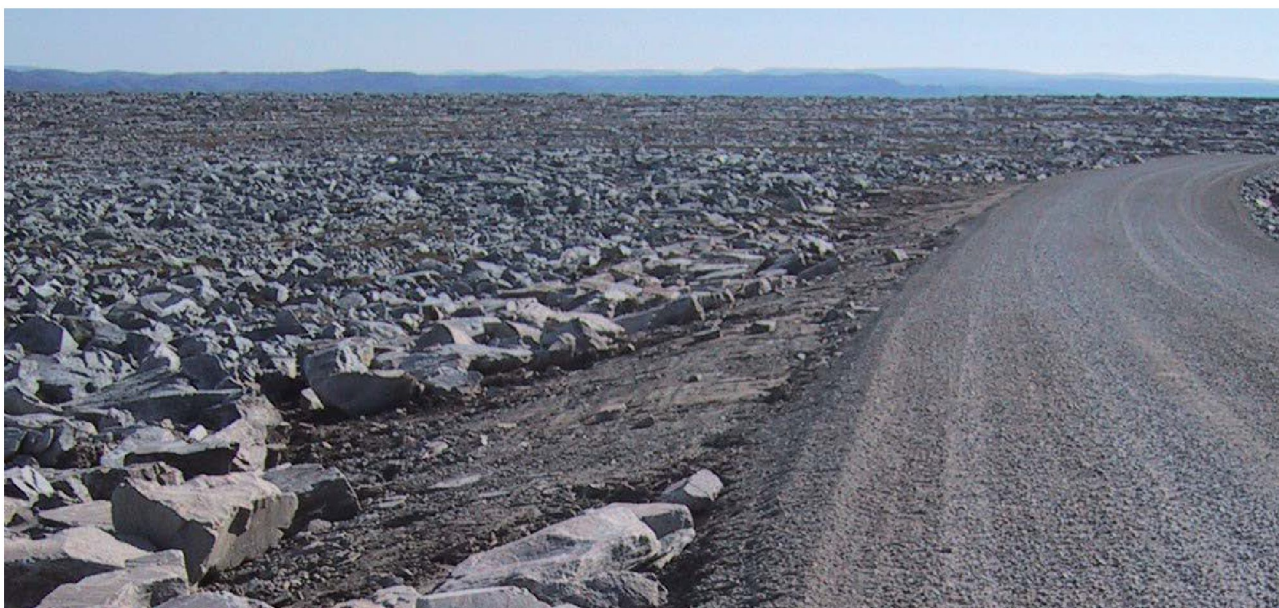
Figur 14 Det vil ikke være nødvendig med grøft er langs veien der det er så godt drenerende masser som her. Overgangen mellom inngrep og eksisterende terreng utføres så mykt som mulig. Stein med fin patinering tas vare på og plasseres tilbake i terrenget med den patinerte siden opp. Fra Kjøllefjord vindpark. Foto: Svein-Rune Wian
