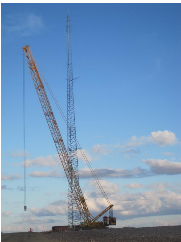
Figur 7. Montering av permanent meteorologimast på Raggo I.
