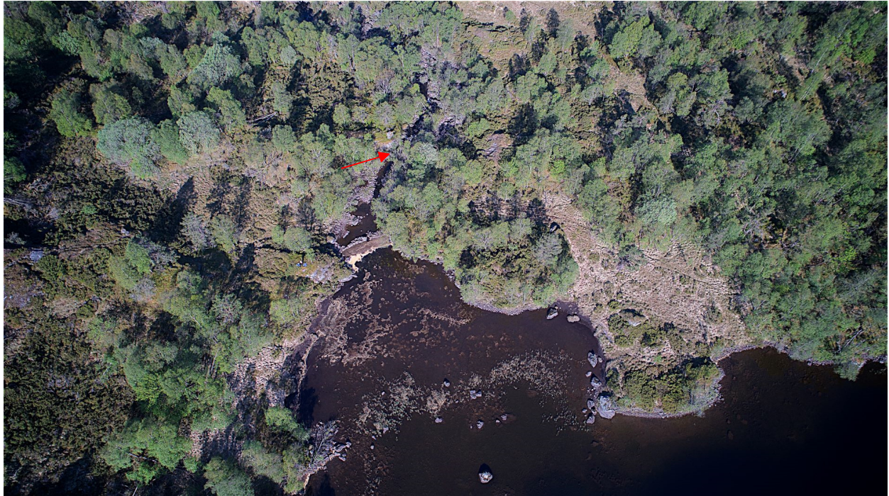
Figur 17 Oversiktsbilde av uløpsområdet. Planlagt plassering av bogedam og lukehus er merkt med ei raud pil. Vedlegg 6 viser fotomontasje av konstruksjonene i terrenget.
