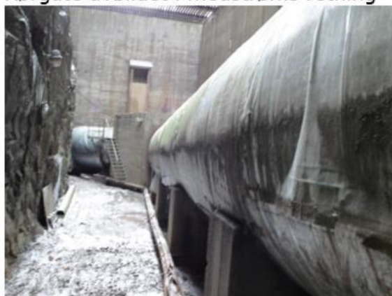
Rørgate avbildet i medstrøms retning
