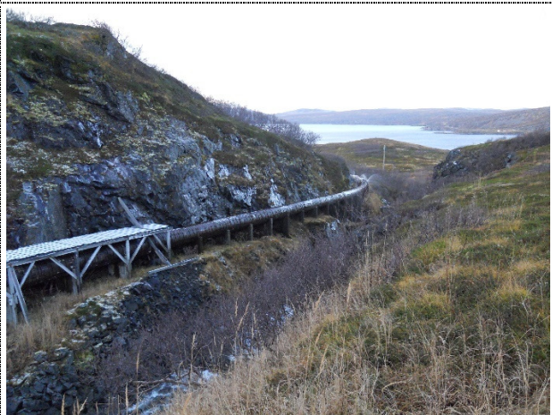
Rørgate ned mot sving
