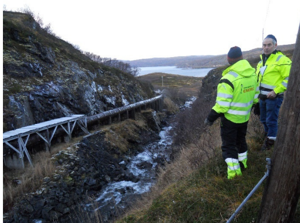
Rørgate parallelt med elveleie langs juv
