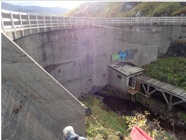
Dam Nedre Eggevatn med buntappeløp og ventilkammer
