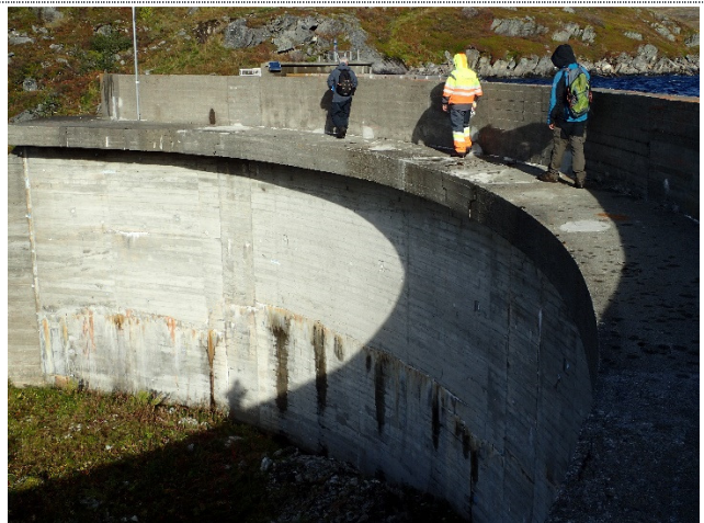
Solpanel og lokasjon for styreskap til ventil i bakgrunnen
