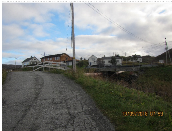
Kryssing av rørgate under riksveibru
