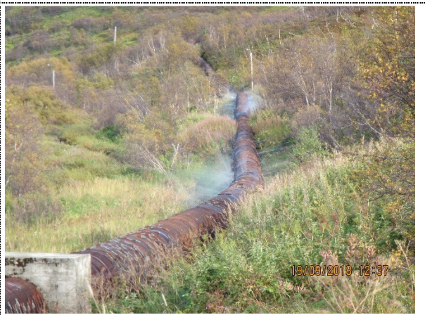
Rørgate opp mot sving
