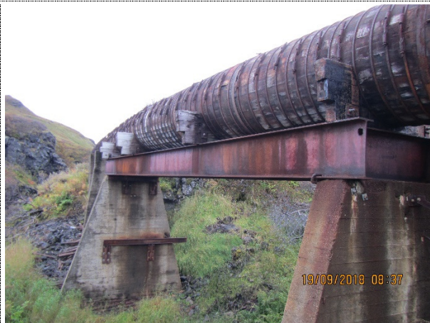
Rørbru ved sving
