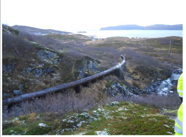
Sving på rørgate
