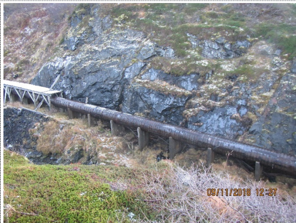
Øvre strekning av rørgate
