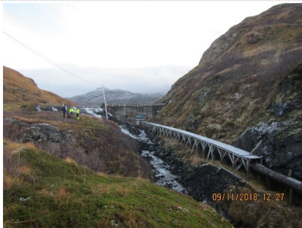
Øvre strekning av rørgate
