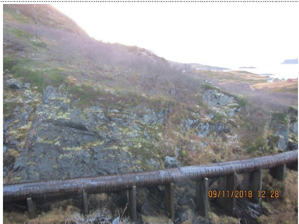
Rørgate ned mot sving
