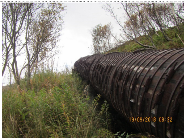
Sving på rør etter at røret forlater elveleiet nedstrøms dam
