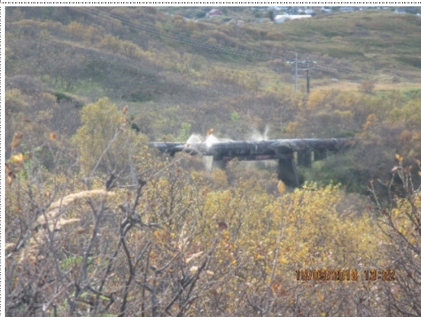
Rørbru ved sving
