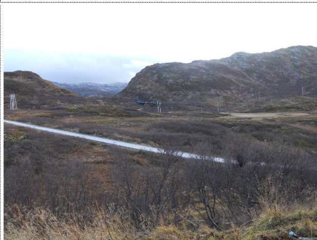
Adkomstvei opp til dam Nedre Eggevatn, rørgate i bakgrunnen
