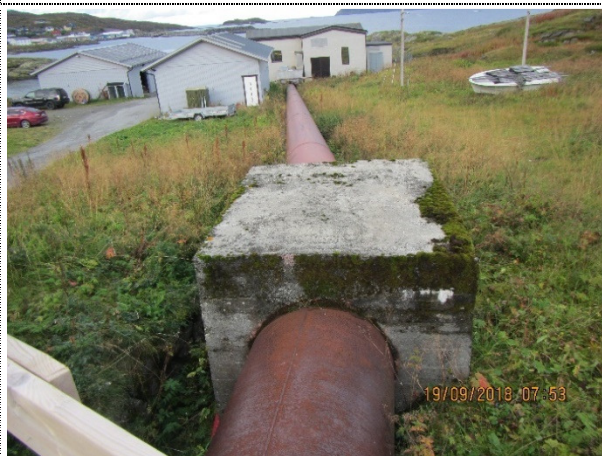
Rørgate sett ned mot kraftstasjon
