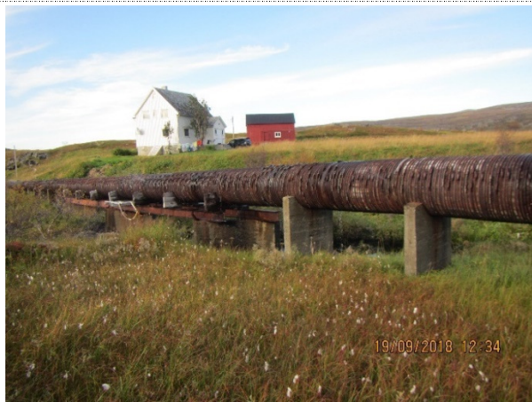
Rørgate med rørbru sett nedover mot riksvei
