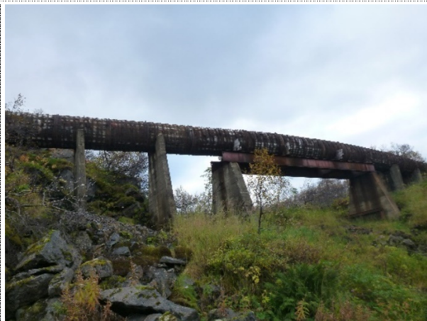
Rørbru ved sving
