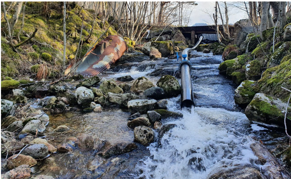
Bilde 9. Et rør er lagt fra Søvatnet og gjennom dammen for å sikre minstevannføringen på 30 l/s. Foto: Torgeir B. Havn, NINA.
