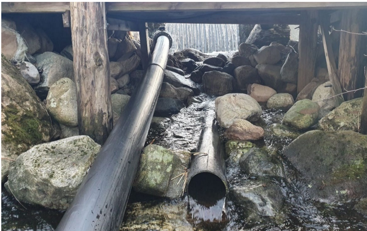
Bilde 8. Kulpen nedenfor overløpsterskelen er delvis fylt igjen med stein, og noe av vannet i kulpen dreneres ut via et rør. Foto: Torgeir B. Havn, NINA.
