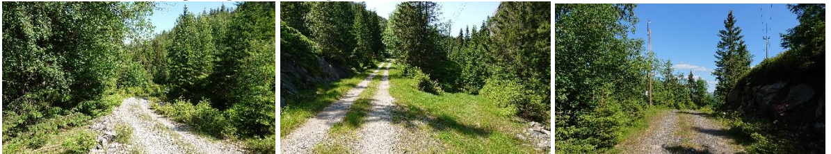
Over sees del av rørtasé langs vei i nedre del, med vei ned til stasjon (midten) og påkoblingspunkt på 22 kV (høyre).
