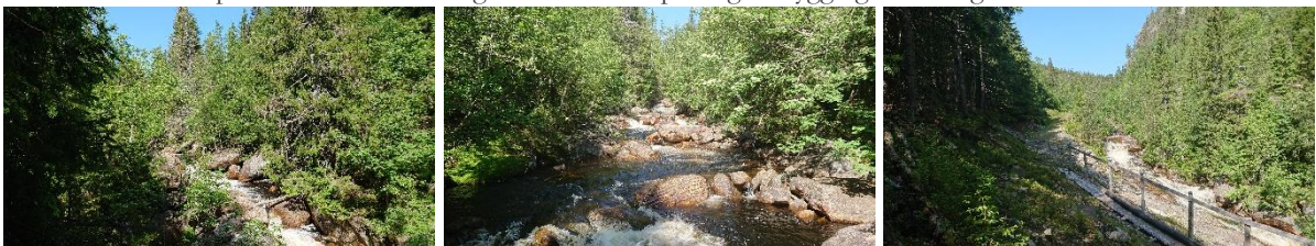
Bildene over viser parti av Buvassselva langs nedre del av planlagt utbyggingsstrekning, med stasjonstomt (høyre).
