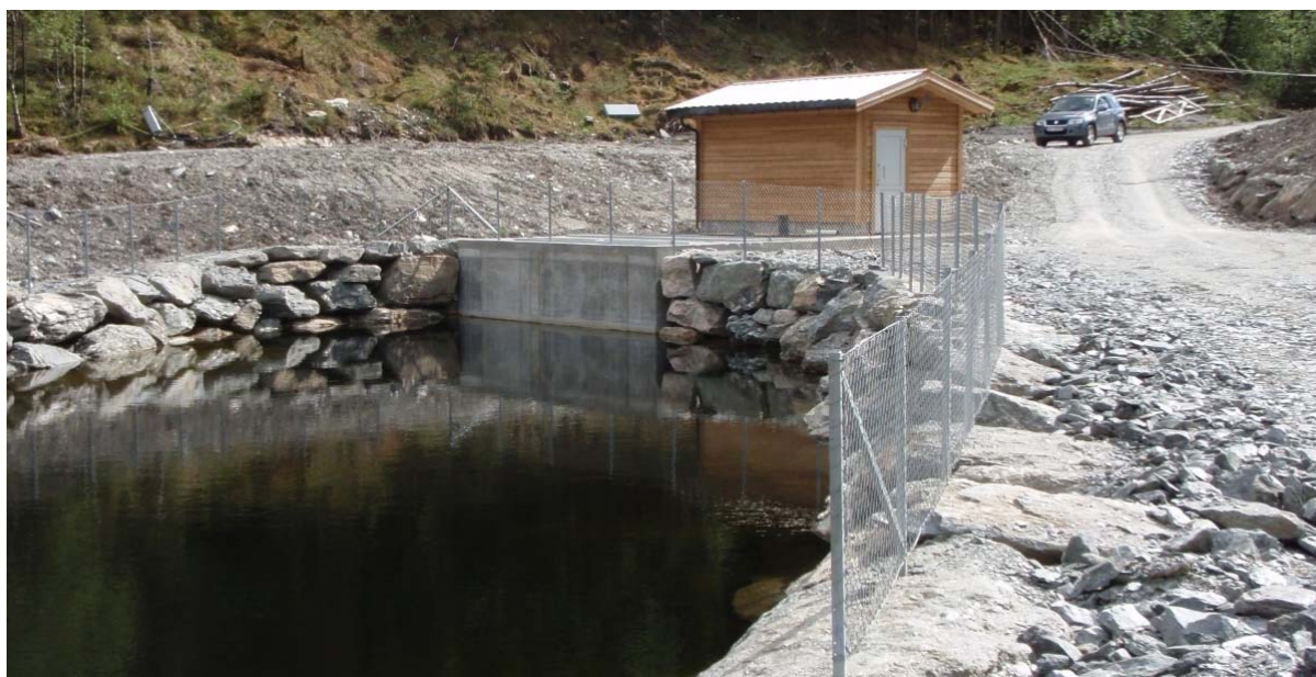
Figur 2-11 Døme på planlagt inntakskonstruksjon
