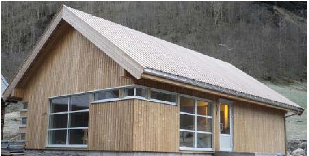
Figur 2-16 Standard utforming av SKL sine småkraftverk.
