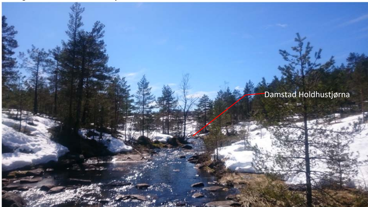
Bilde 7: Trasé overføringsrøyr til høgre i bilde.
