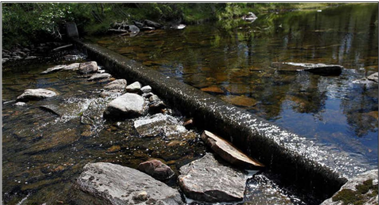
Figur 1.2: Terskel ved utløp Holdhustjørna den 5/7 2017, vassføring 0,33 m 3 /s (Foto: A. Håland)
