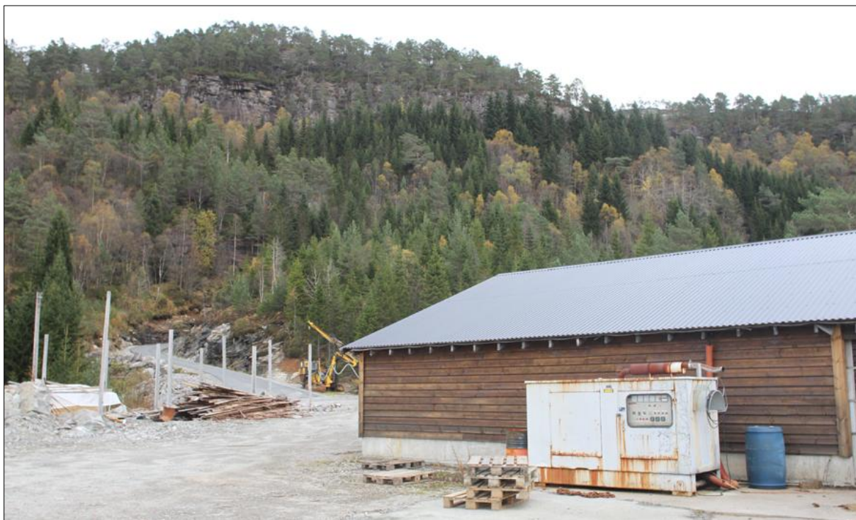
Fig. 56. Teknisk anlegg ved veien sentralt i dalen. 17. okt. 2012. Foto: A. Håland.
