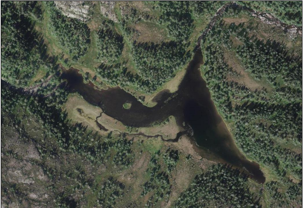
Fig. 18. Holdhustjørna er i hovedalternativet planlagt som regulerbart inntaksmagasin. Innløpet er i venstre kan av bildet, utløpet oppe i kanten til høyre.
