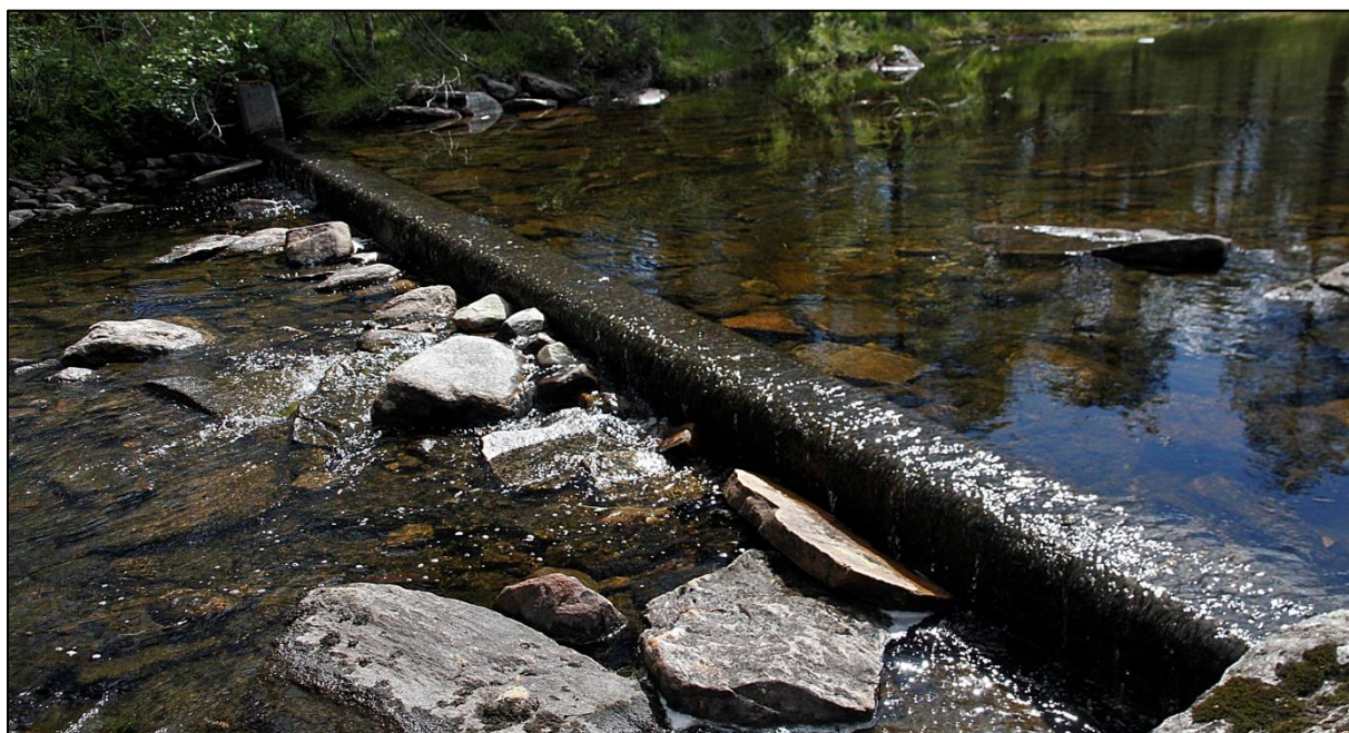
Fig. 73. Holdhustjørna er en grunn, mindre vannforekomst der vannstanden i dag er påvirket av en liten betongterskel i utløpet, etablert etter tidligere utbygging av vassdraget. 5. juli 2017. Foto: A. Håland.
