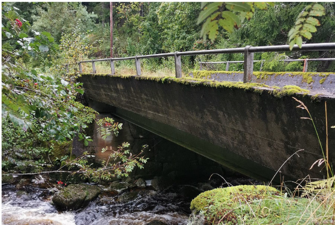
FIGUR 20 BRU PÅ LUNDEVEIEN
