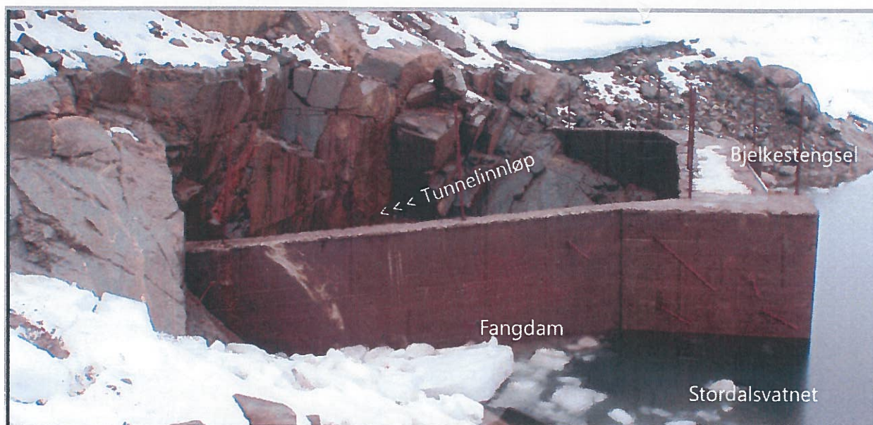
Figur 4 Det er bygget en fangdam framfor inntaket i Stordalsvatnet. Bjelkestengsel i fang som benyttes for å kontrollere vannstand og tilsiget under arbeidet på luka. Her er vannstand på kote 439 (foto fra 2010)
