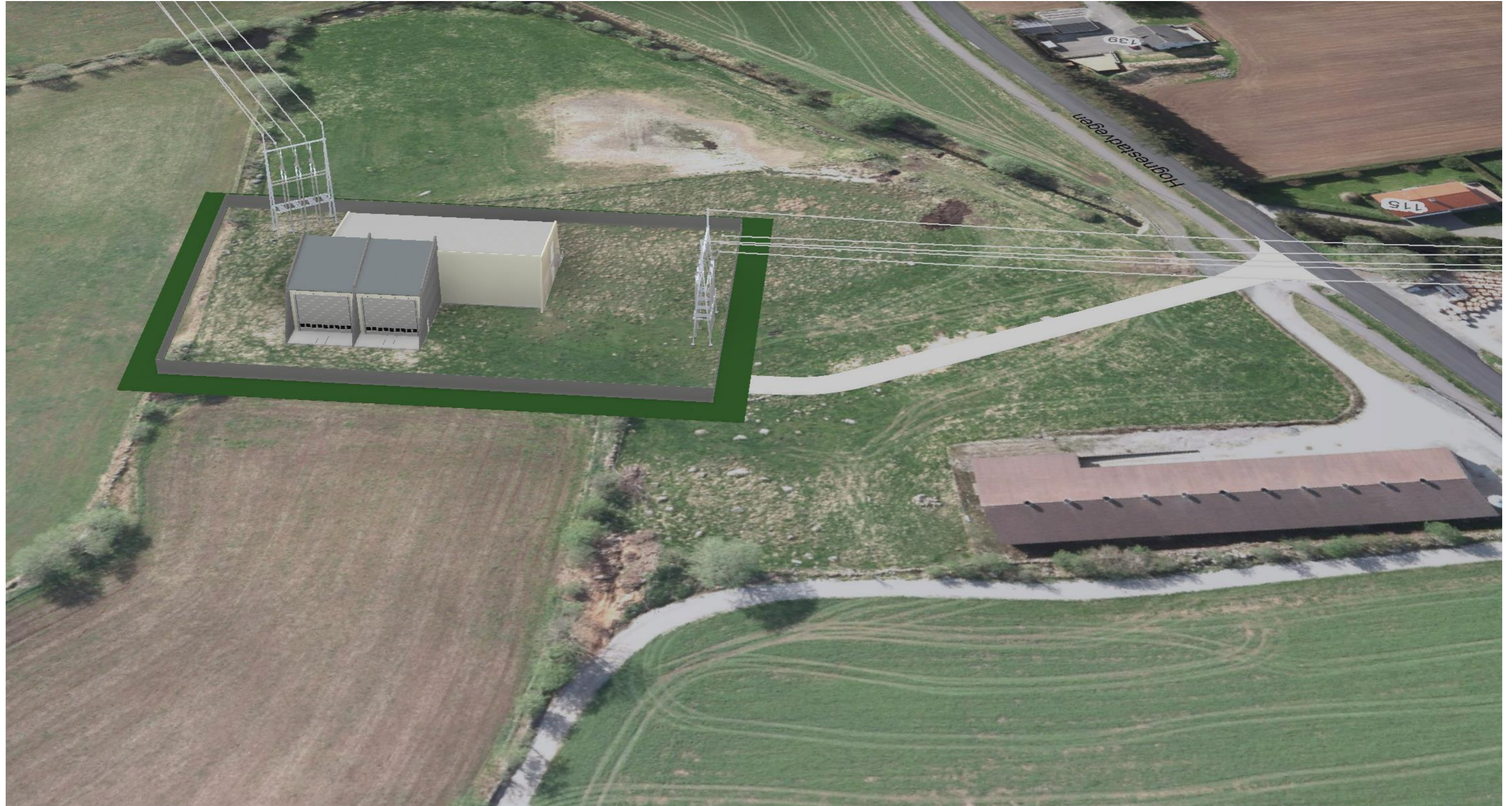
Nye Håland transformatorstasjon sett fra nord mot sør.
