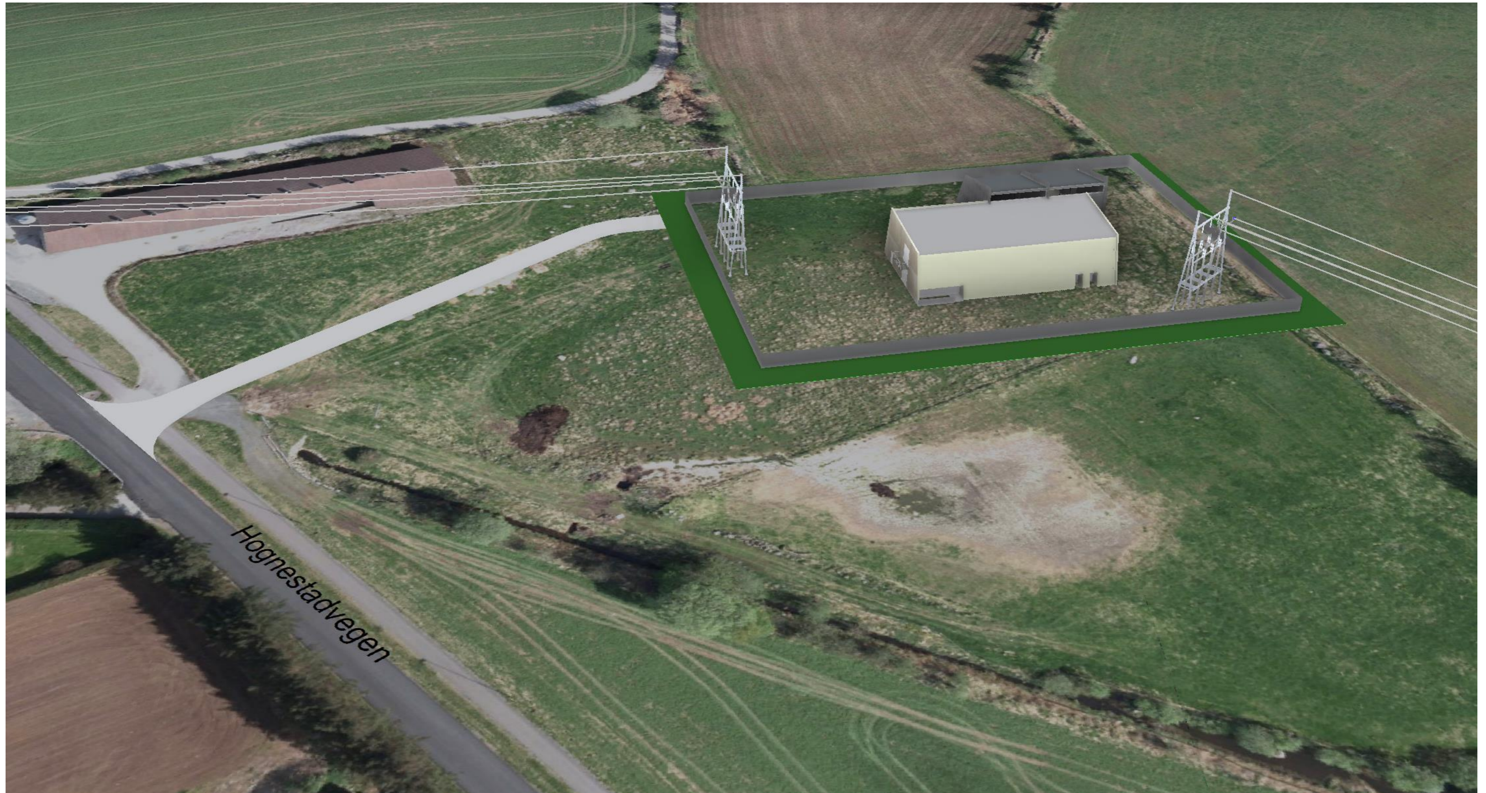
Nye Håland transformatorstasjon sett fra sør mot nord.
