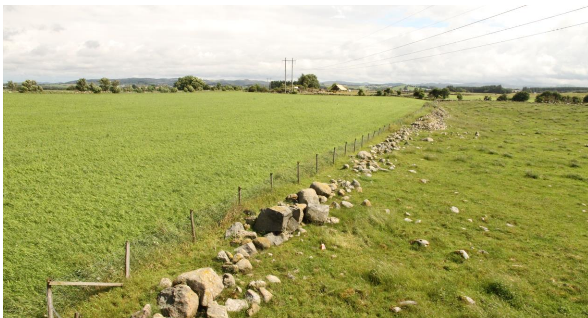
Figur 6.17. Typisk landskap og vegetasjonstrekk i traséområdet. Her nær Hatteland transformatorstasjon.
