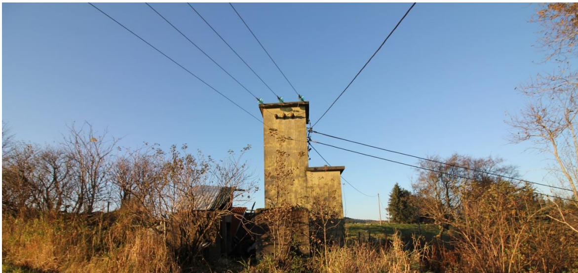
Figur 6.45. Ruin, grunnmur i betong, synleg med tak på ortofoto 1937. Mot nord.
