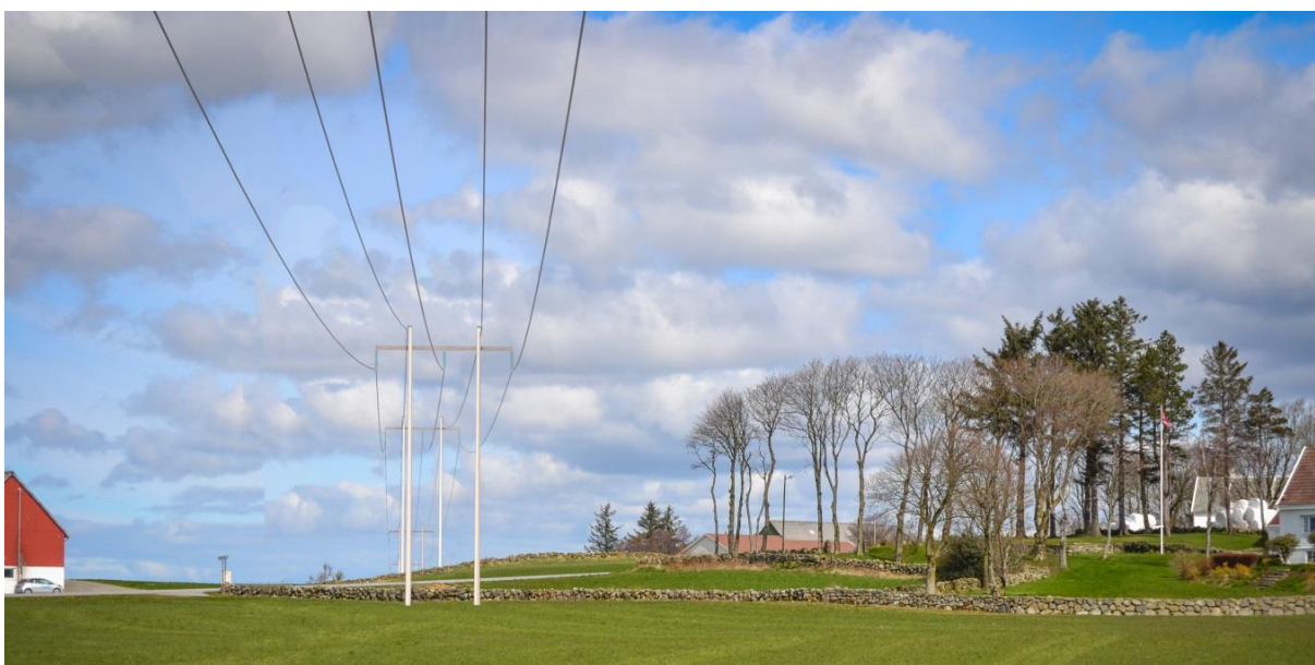
Figur 6.13. Time, nedenfor Prestegarden sett mot nord.
