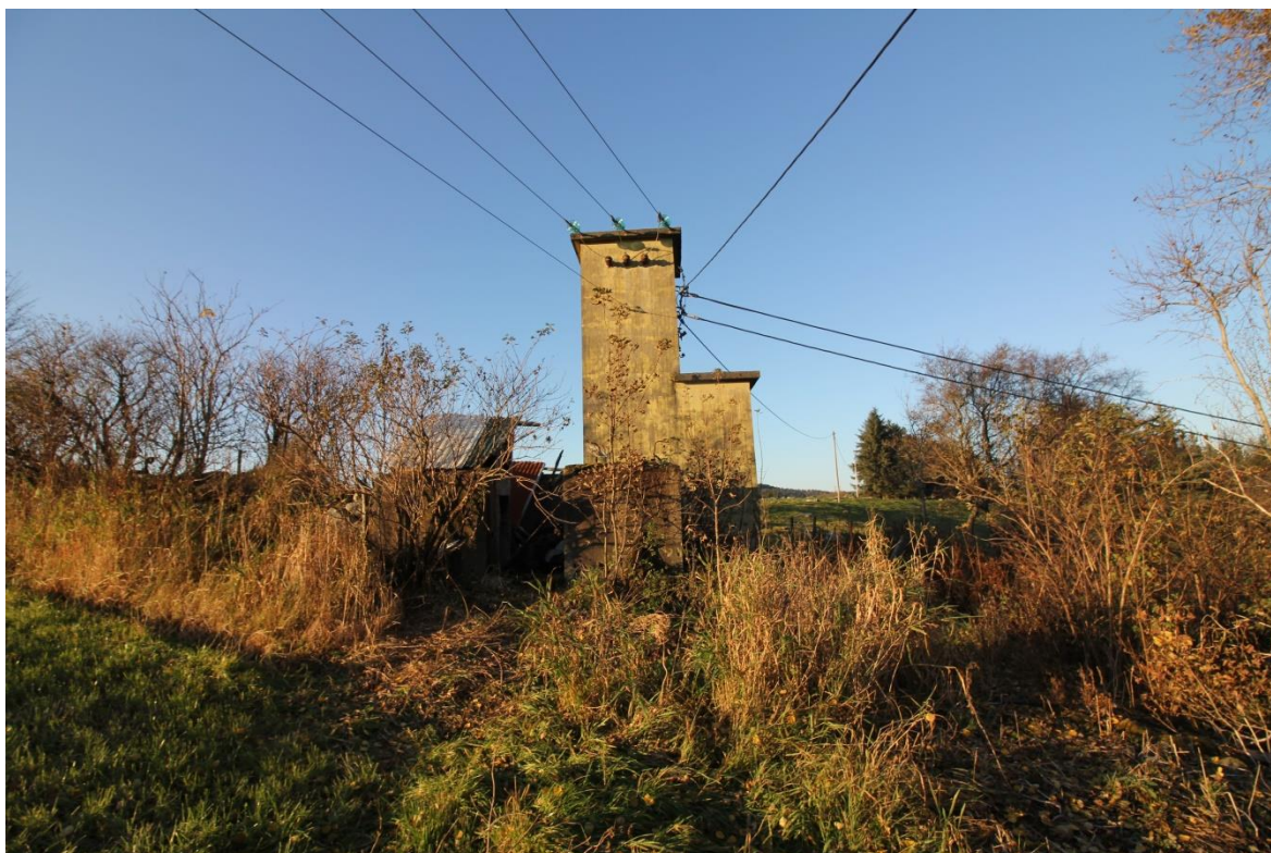
Figur 23. Ruin, grunnmur i betong, synleg med tak på ortofoto 1937. Mot nord.
