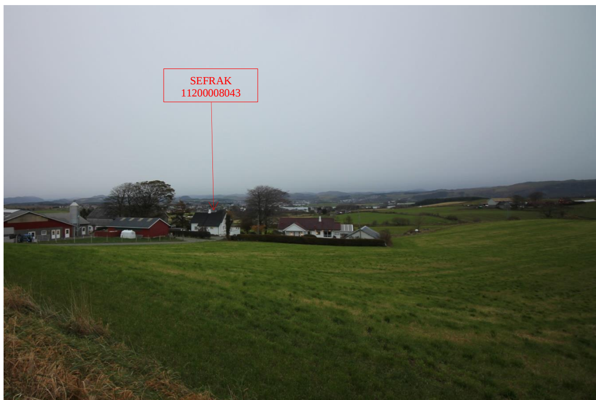
Figur 51. SEFRAK 11200008043, våningshuset med svart tak, mot nordaust.
