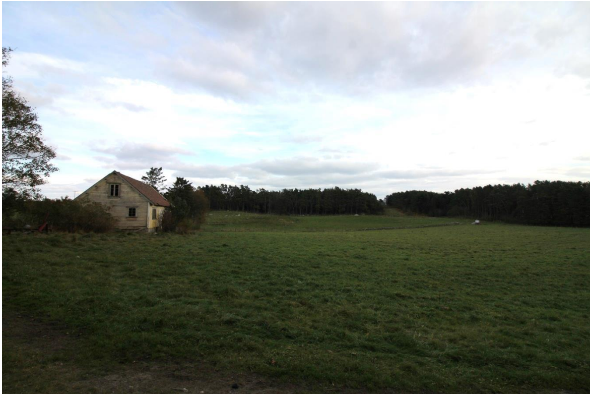
Figur 36. S 2, eldre våningshus/driftingsbygning i relasjon til kulturbeite. Mot nord.
