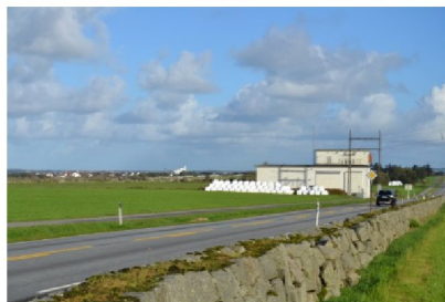
Opstad, nytt GIS-anlegg.
