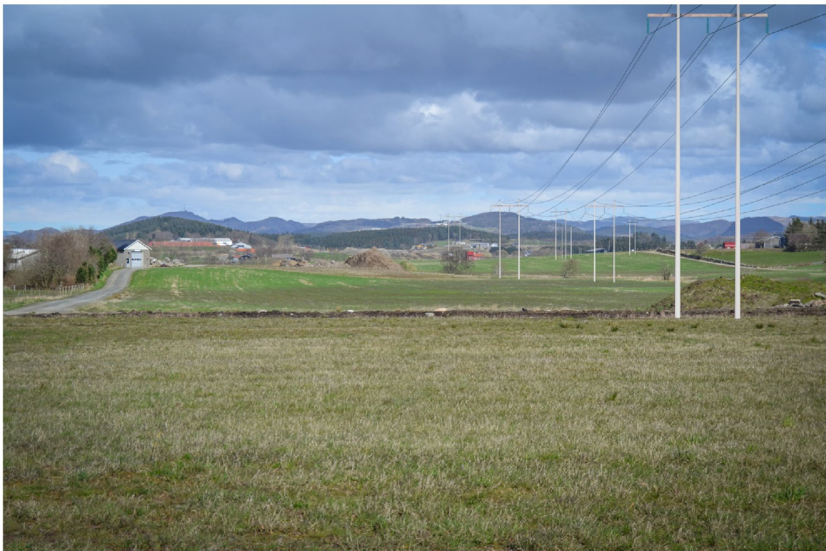
8. Gruda, to enkeltkurser sett mot nordøst.
