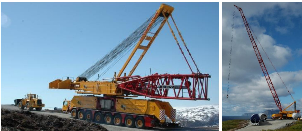
Figur 4-3 Eksempel på mobilkran for montasje av vindturbiner – fraktes delvis montert internt i vindparken.
