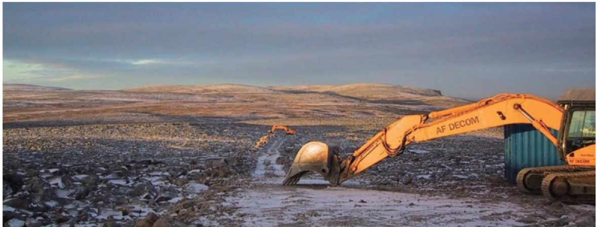
Kjøring med maskiner skal holdes så nær veilinja som mulig slik at ikke vegetasjon som lyng og lav tar unødvendig skade. Fra Kjøllefjord vindpark. Foto: Svein-Rune Wian.
