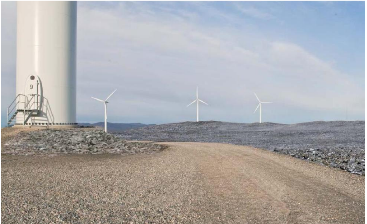
Turbinfundamentet er hevet ca. 1 meter over kranoppstillingsplassen. Denne utformingen mangler visuell forankring til plassen. Eksempel fra representativ vindpark i Finnmark. Foto: Einar Berg
