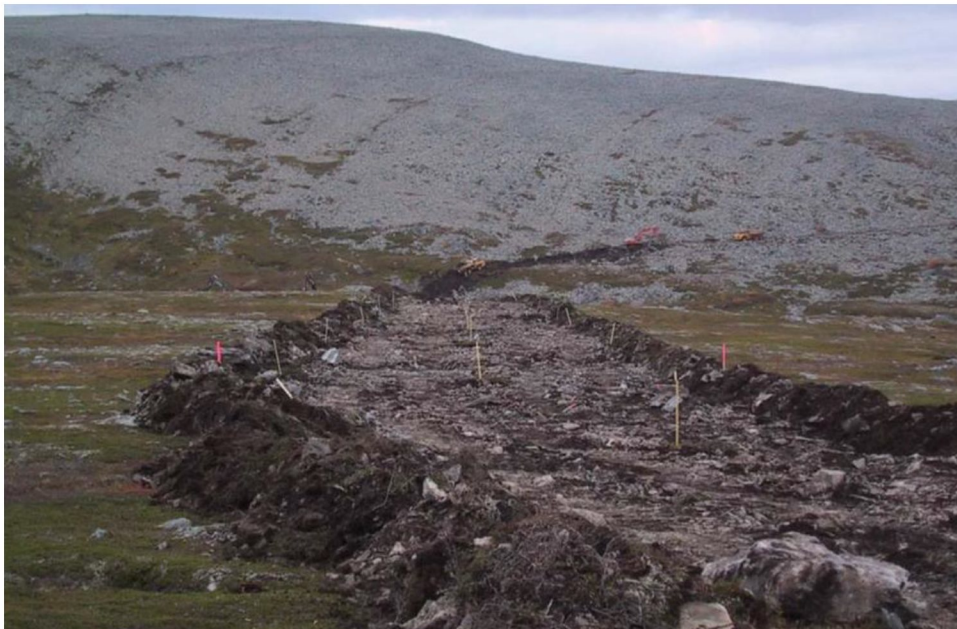
Toppdekket skaves av og legges i ranker på siden. Det skal tilstrebes at topplaget legges tilbake så fort som mulig og ikke mellomlagres for lenge. Eksempel fra Kjøllefjord vindpark.
