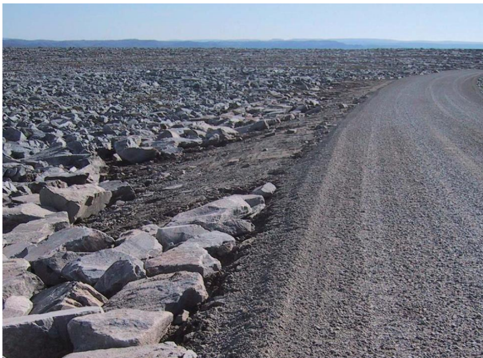
Overgangen mellom inngrep og eksisterende terreng utføres så mykt som mulig. Stein med fin patinering tas vare på og plasseres tilbake i terrenget. Fra Kjøllefjord vindpark. Foto: Svein-Rune Wian
