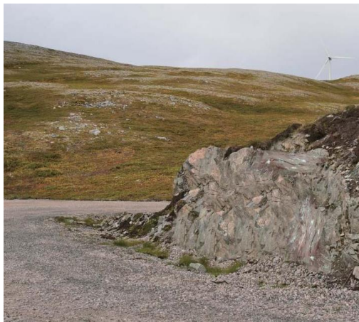
Fjellskjæring uten tiltak. Foto: Einar Berg
