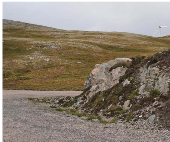
Masser er trukket ned fra toppen av fjellskjæringen. Dette gir bedre landskapstilpasning og visuell forankring. Fotomontasje: Einar Berg
