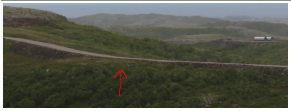
Figur 9: Eksempel på vei som er bygget på fylling, men hvor det eksisterende terrenget bryter fyllingen. På denne måten blir veien bedre tilpasset landskapet og veien blir ikke så synlig på avstand. Foto: NVE
