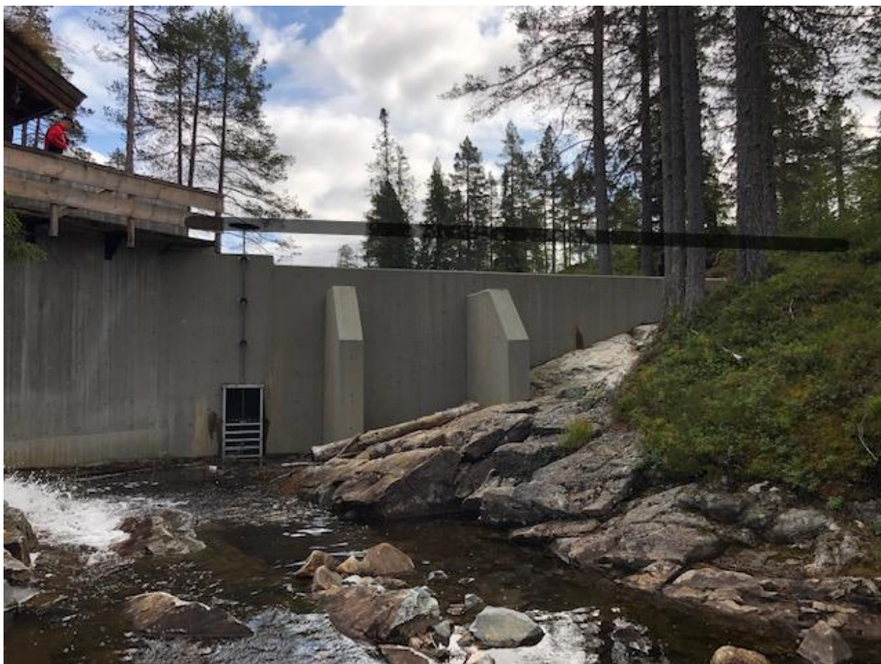
Figur 4. Eksisterende dam forhøyes med 1,2 meter og forsterkes med å føre støtteribber lengre opp. Ny høyde indikert med svart strek.
