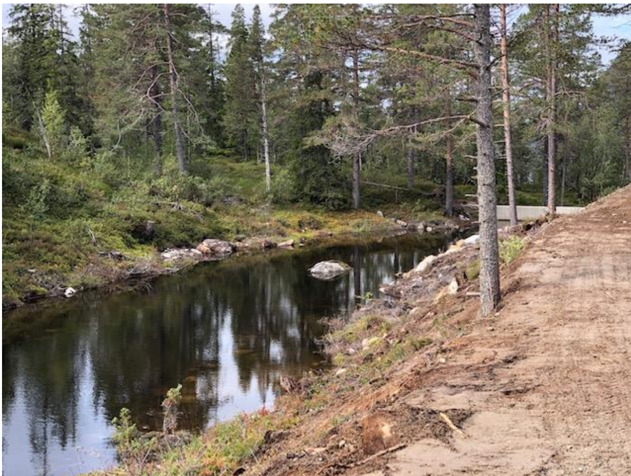
Figur 18. Utløpsosen/inntak sett ovenfra. Driftsvei som sees til høyre er blitt rettet av og blitt forlenget sørover forbi Svartetjørn.
