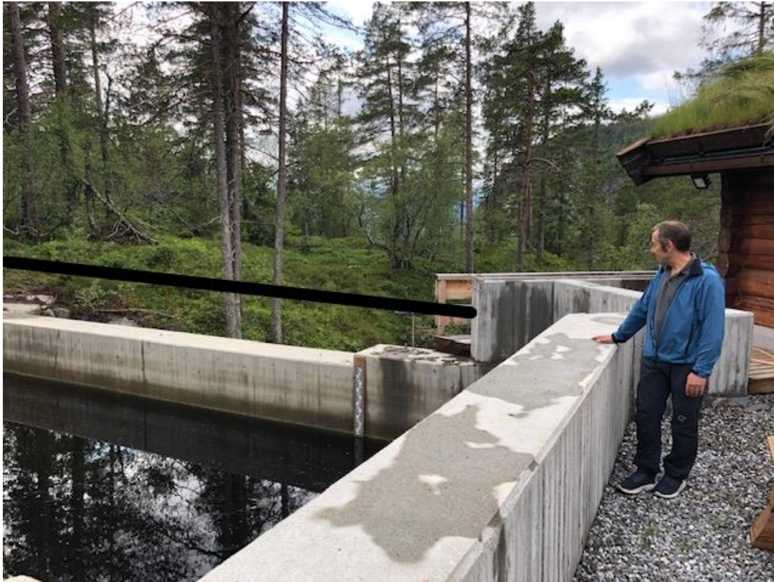
Figur 5. Ny damhøyde indikert med svart strek. Kant mot dambua vil bli vurdert forhøyet noe.
