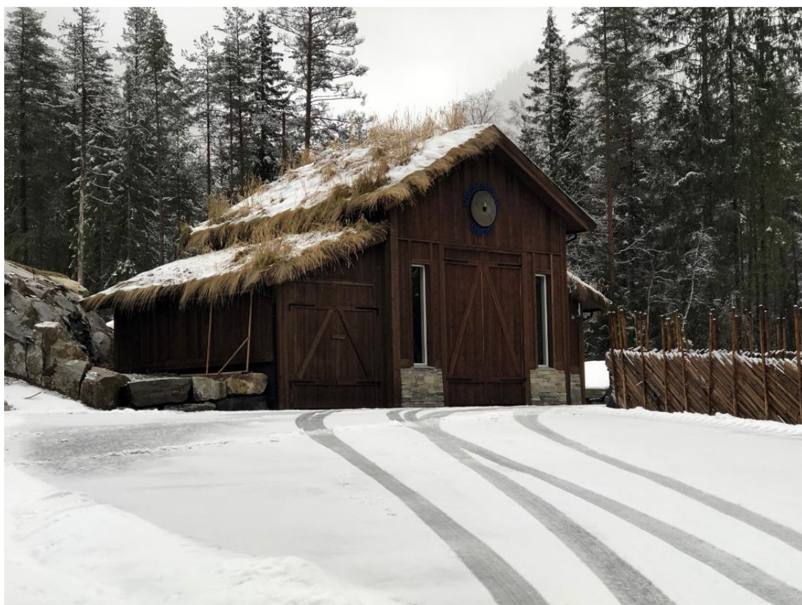
Figur 8. Straume kraftverk omtrent slik brukere av Via Ferrataen vil se det når de passerer stien som går videre fra rørgatetraseen ned mot veien som går på østsiden av Otra.
