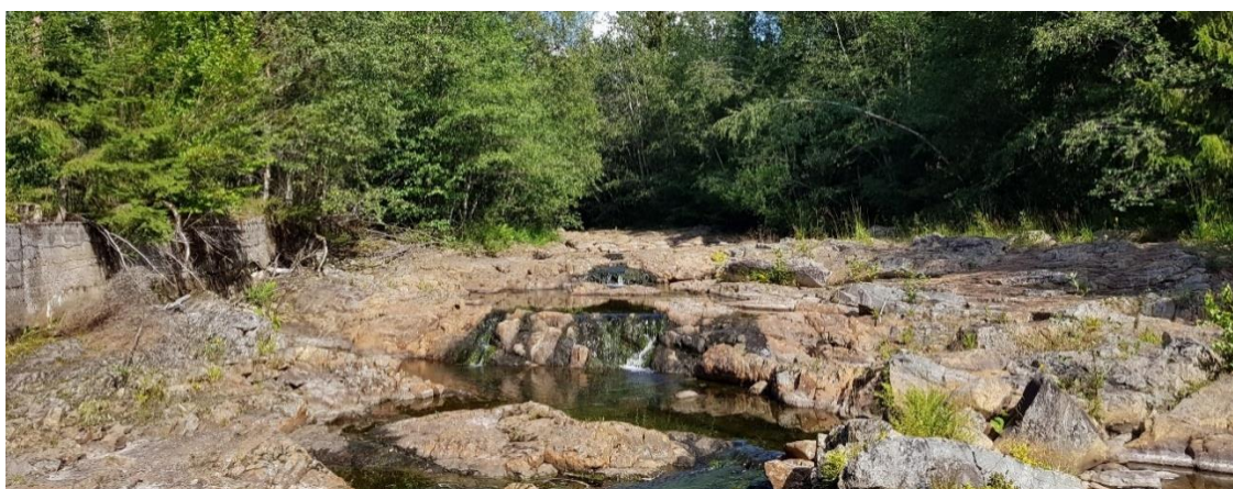
Figur 16 Bilde oppstrøms utløpet av Flittig kraftstasjon i Moelva
