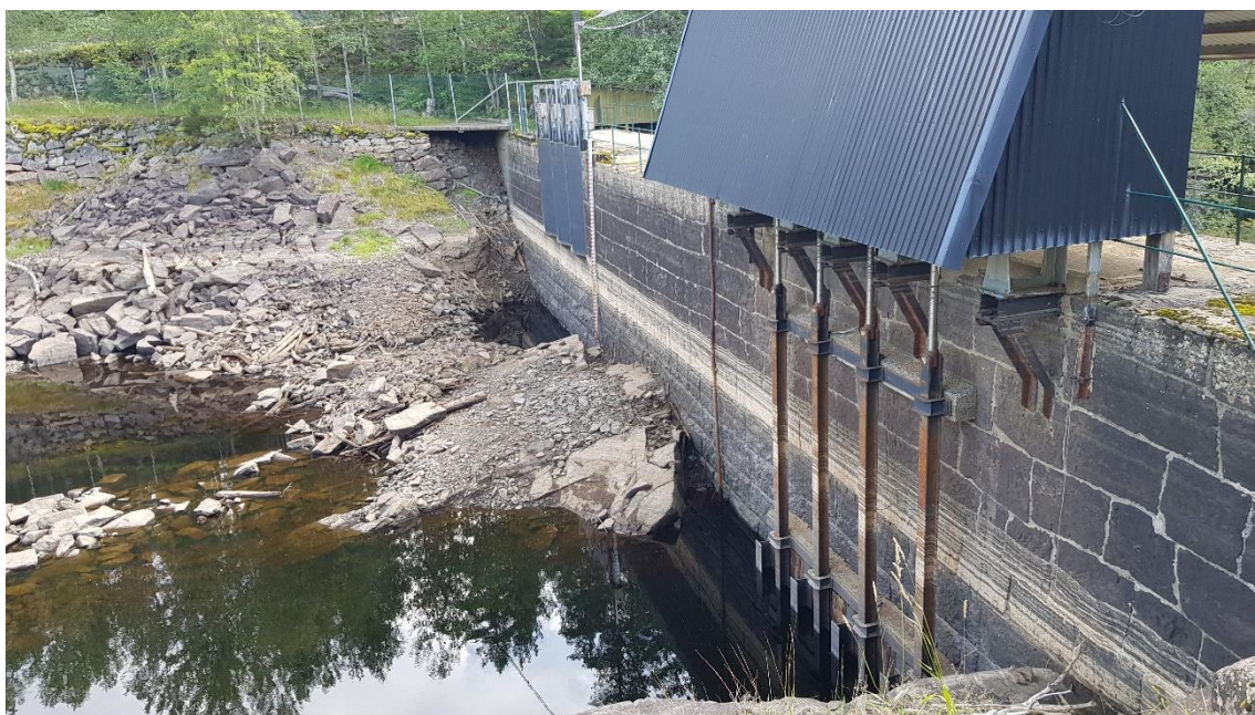
Figur 2 Hoveddammen i Fjellvannet.
