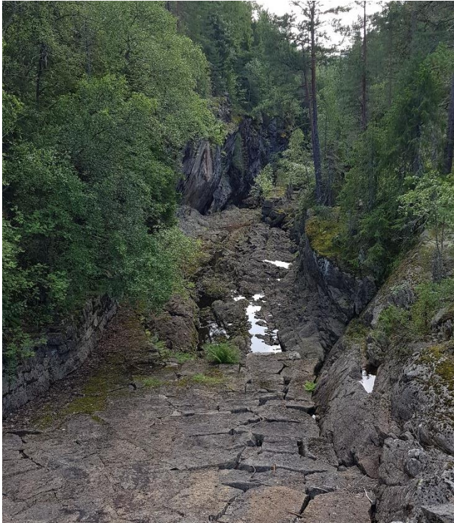
Figur 3 Vestre løp sett fra hoveddammen i utløpet av Fjellvannet.
