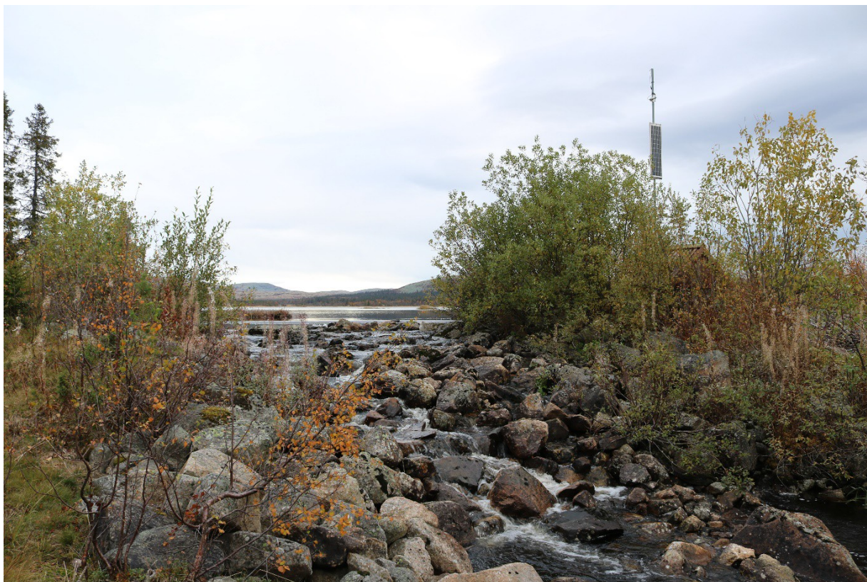
Figur 9. Overløp dam Hundsjøen. Taket på et ventilhus skimtes til høyre for overløpet.
