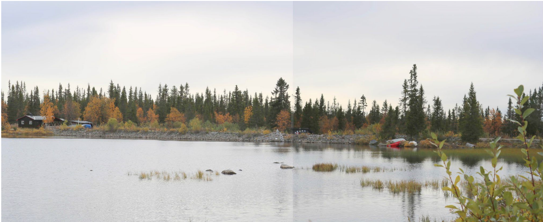
Figur 18. Hoveddam Lille Hyllsjø, med vannstand 6 cm under HRV. Det dykkede kraftverksinntaket er plassert foran tregjerdet sentralt i bildet. Hytta i venstre bildekant ligger tett inntil dammen.
