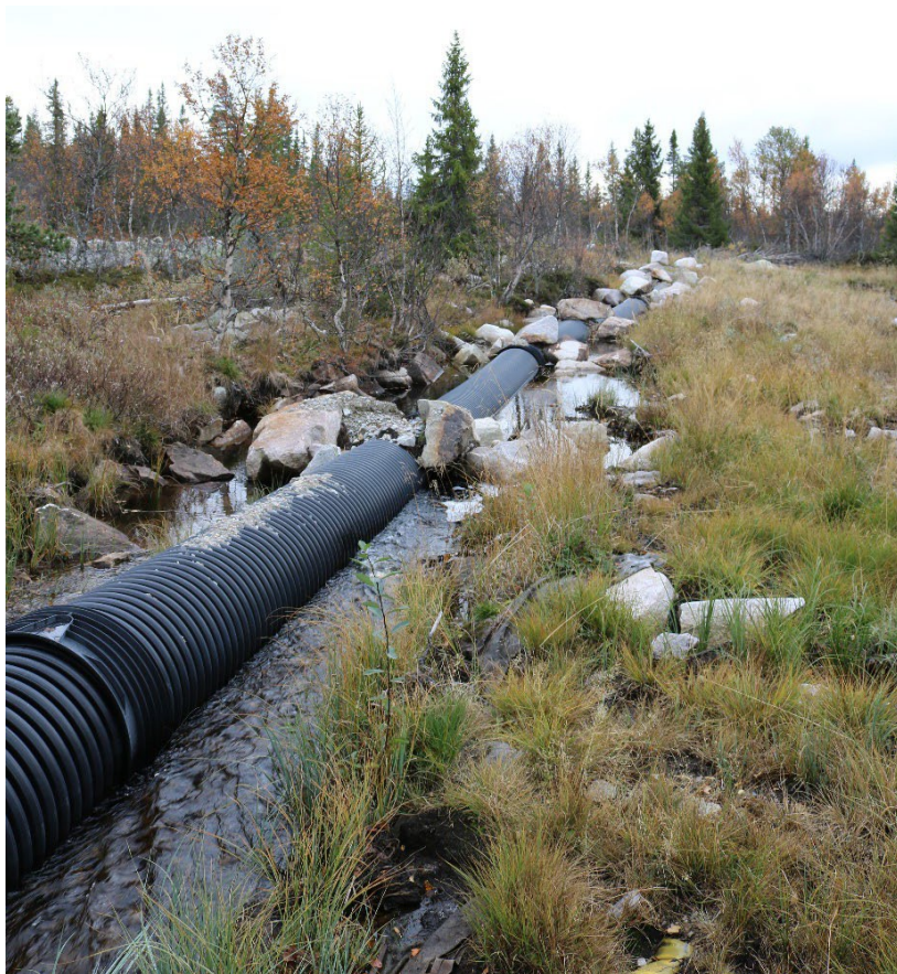
Figur 13. Ved overføringen av Hundsjøbekken er det lite fall, og det har vært utfordringer med å få ledet vannet inn i overføringskanalen. Dette har vært forsøkt løst ved hjelp av lett maskinelt utstyr, og en midlertidig rørgateløsning. EVK er ikke tilfreds med løsningen og ønsker å utbedre partiet både teknisk og landskapsmessig.
