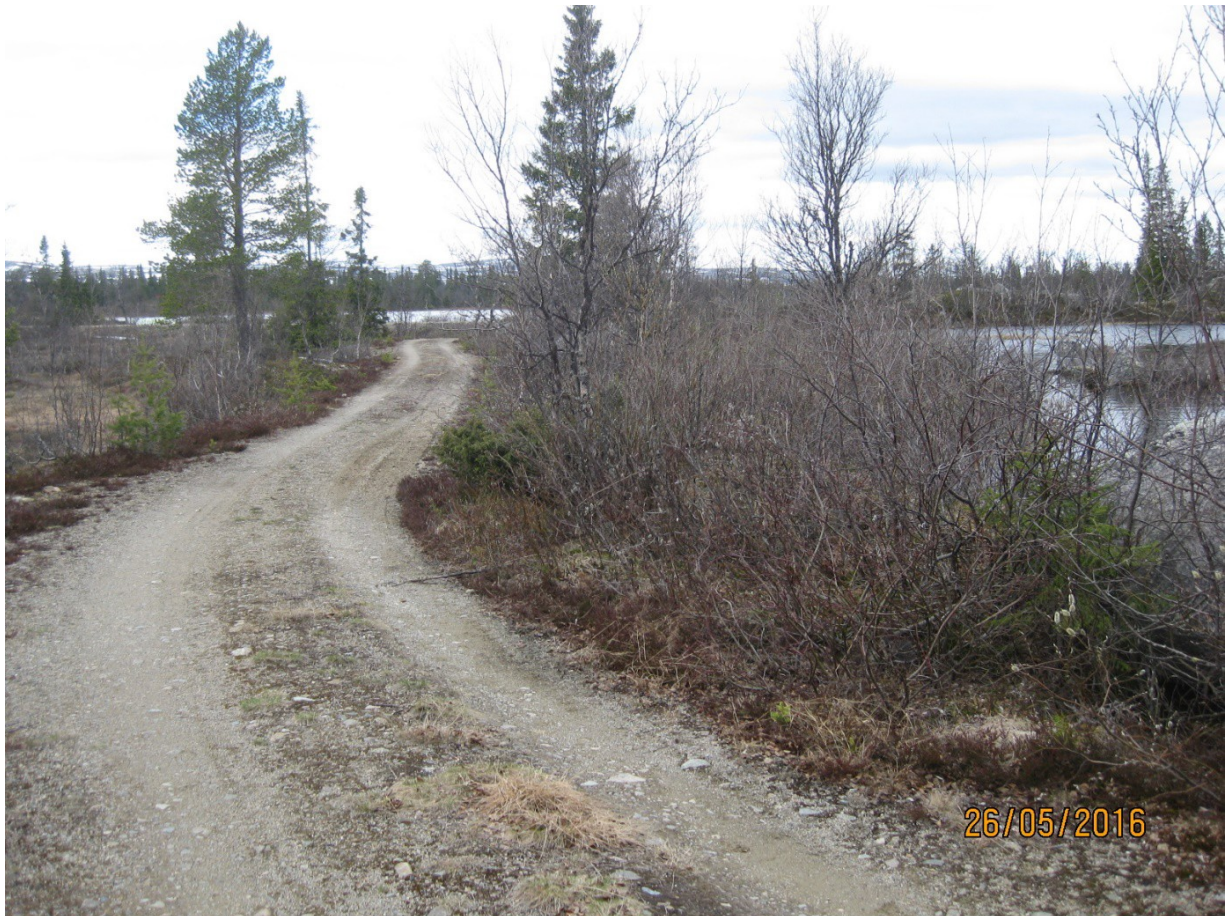
Figur 15. Hoveddam Store Hyllsjø. Det er anlagt veg over dammen.
