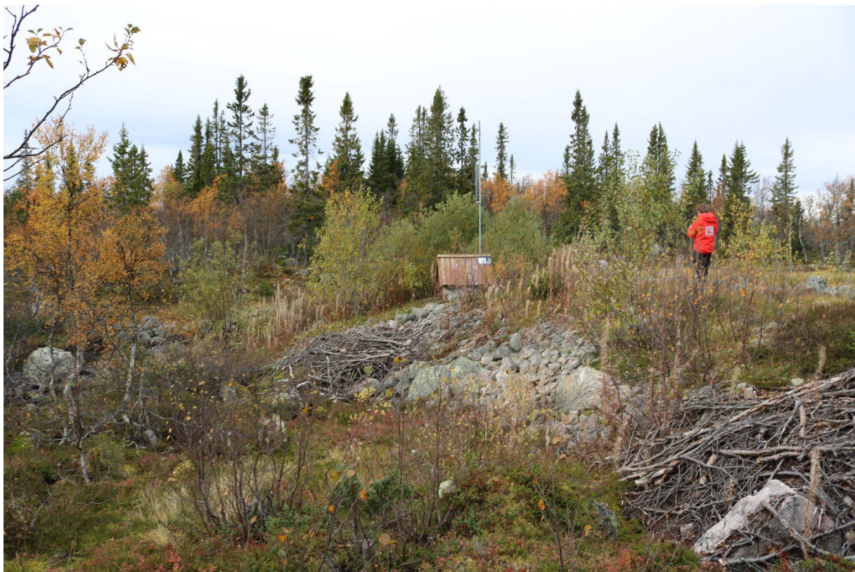
Figur 12. Dam Hundsjøen, nedstrøms side med ventilhus midt i bildet.
