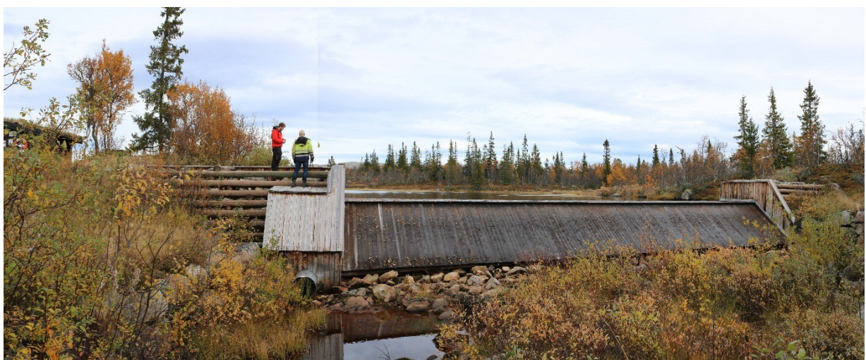
Figur 16. Sekundærdam Store Hyllsjø er en tømmerkistedam.
