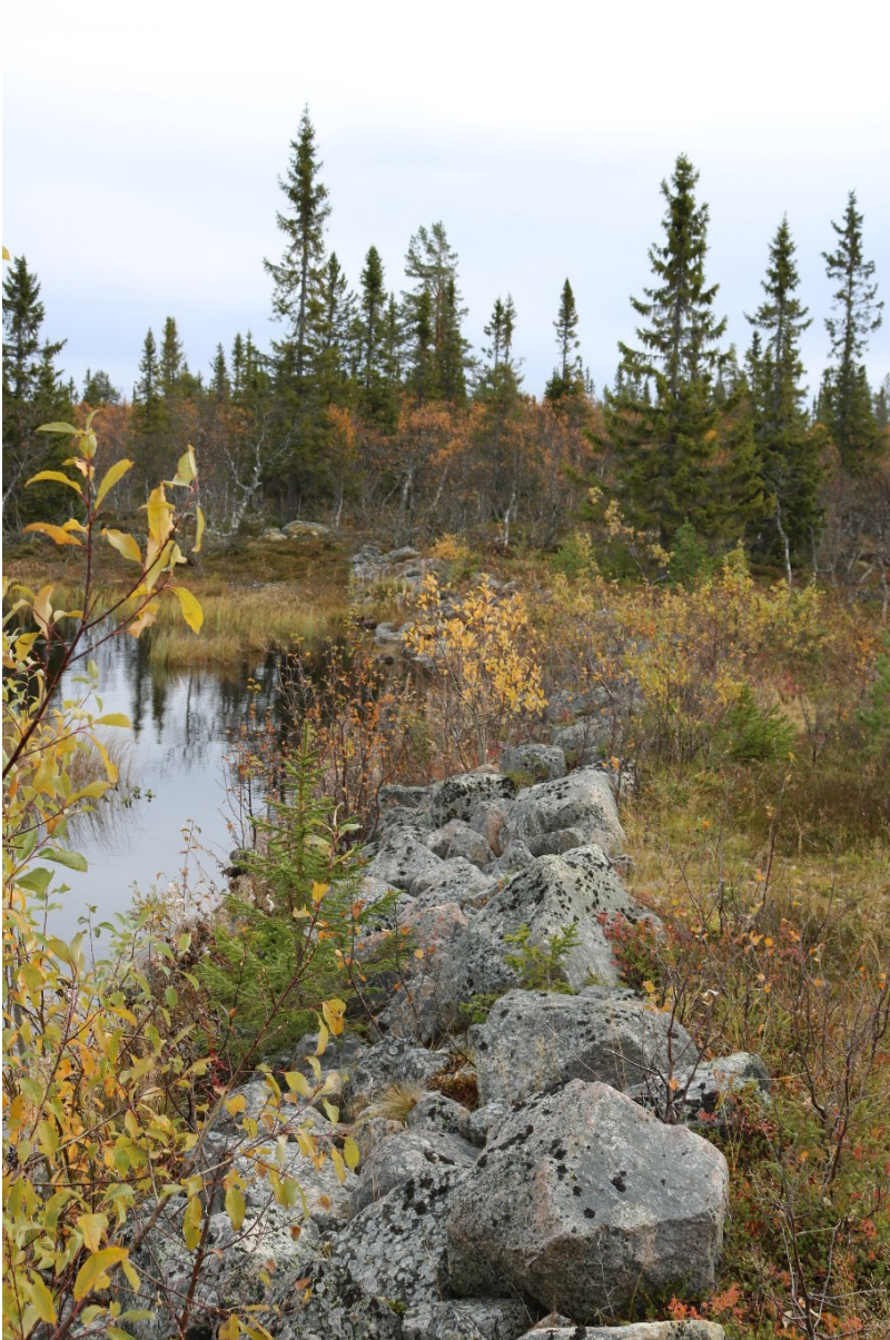
Figur 11. Dam Hundsjøen, mot østre landfeste.
