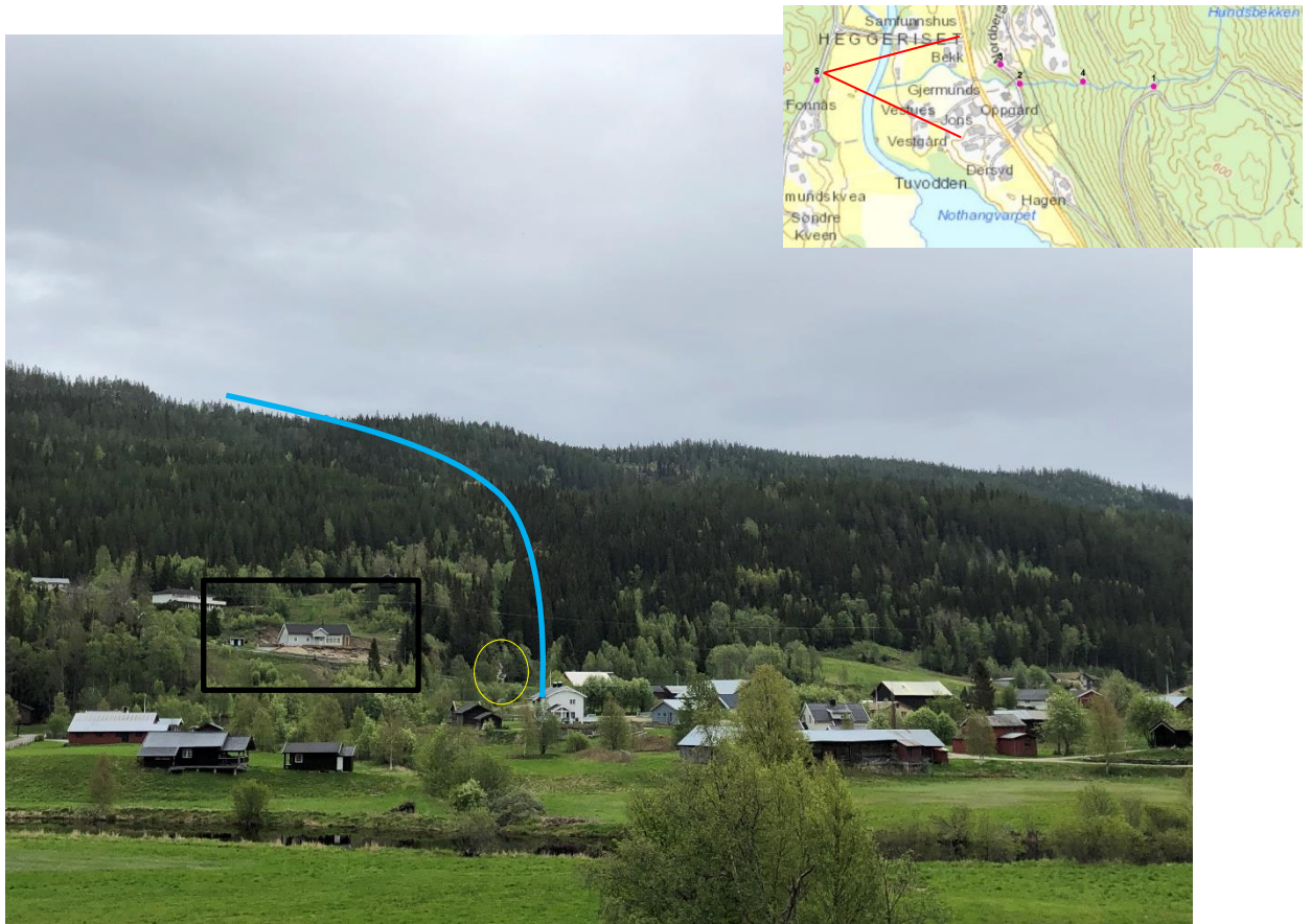
Figur 15 Oversiktsbilde over viften nedenfor Hundsbekken, se illustrasjon oppe i høyre hjørne på ca. synsvinkel. Svart firkant markerer hvor bildet i figur 12 er tatt, og gul sirkel viser hvor Hundsbekken krysser Nordberget-veien. Ser man godt etter på venstre side av den blå streken ser man søkket i terrenget som viser hvor Hundsbekken går (Foto: Agathe Alsaker Hopland).
