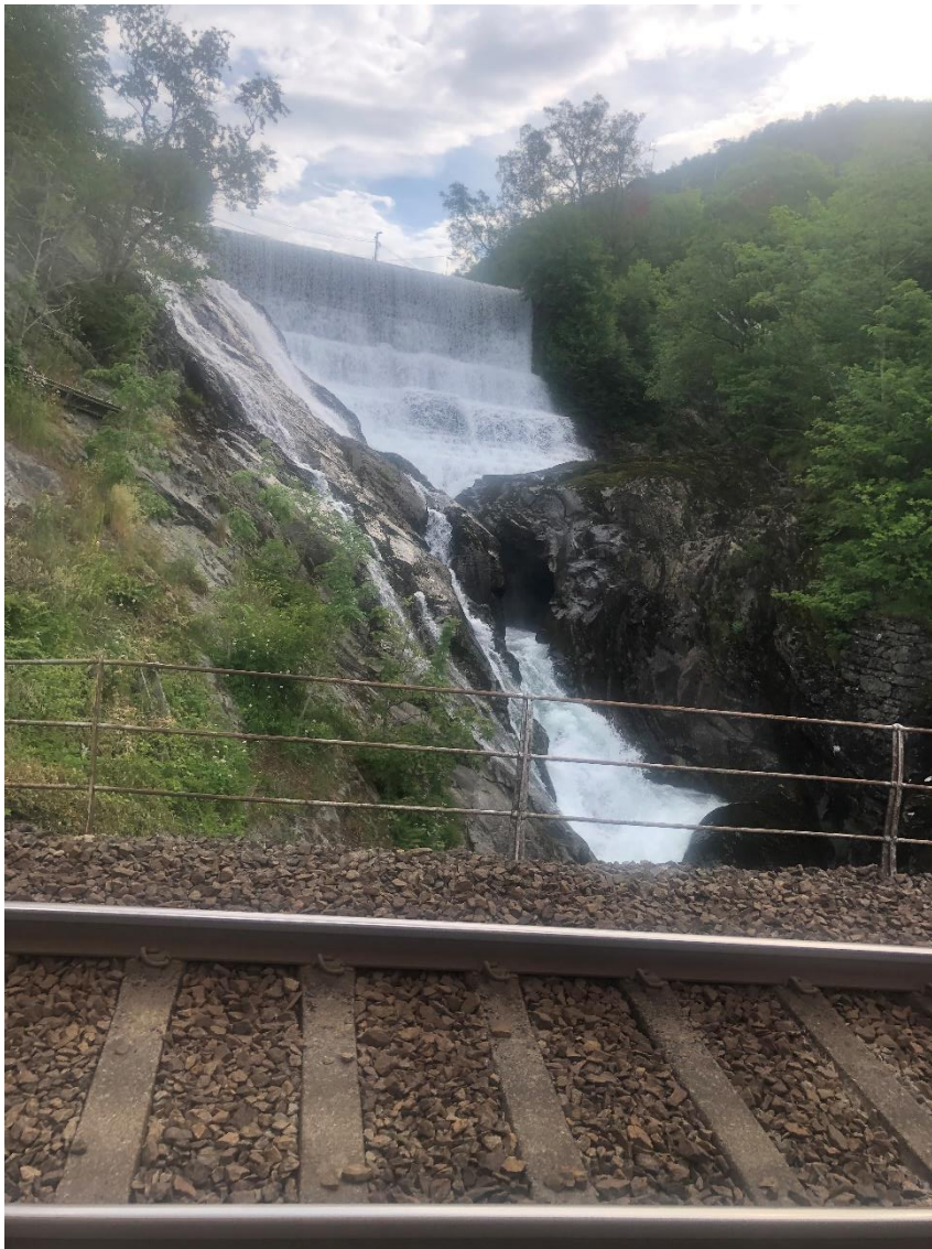
Bilde 1 Dam Trollkjen, sett fra jernbanebru
