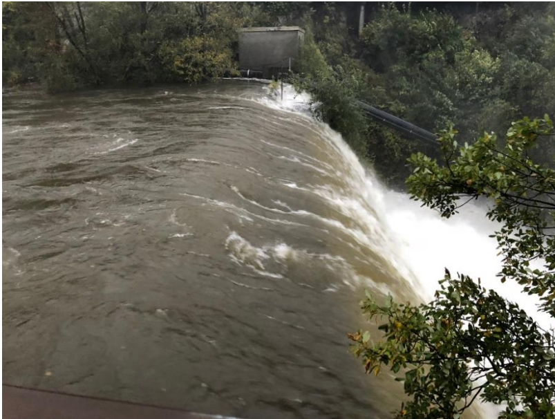
Bilde 4 Flomvannstand, damkrone overtoppes også. Vannføring ca. 10-års flom (september 2018).
