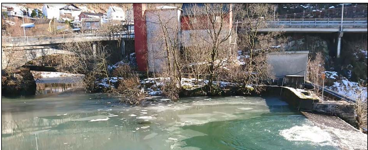
Figur 5. Vannspeil som dannes av dammen, sett nordfra fra Trollkjelsvegen. Foto: Småkraft AS
