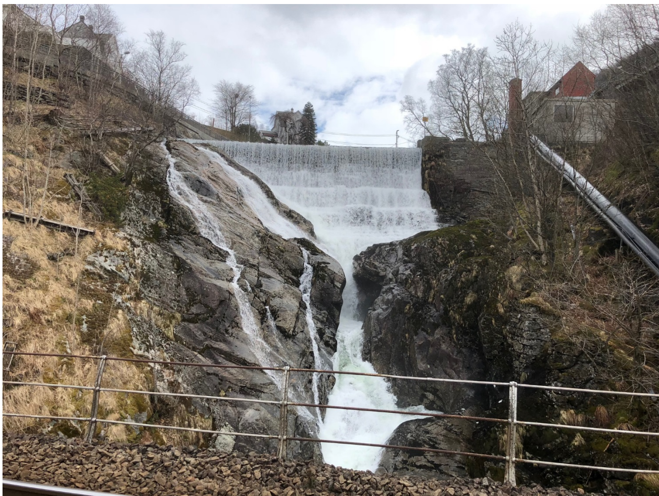
Fig. 7: Dammen sett fra Bergensbanen. Foto: Småkraft AS
