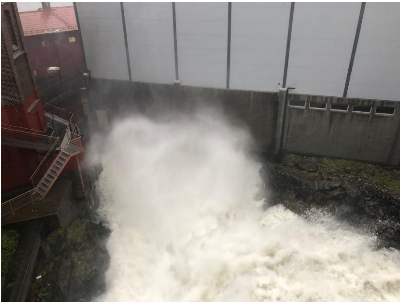
Bilde 7 Vannføring ved innløp til flomkanal under Vaksdal Mølle (september 2018).
