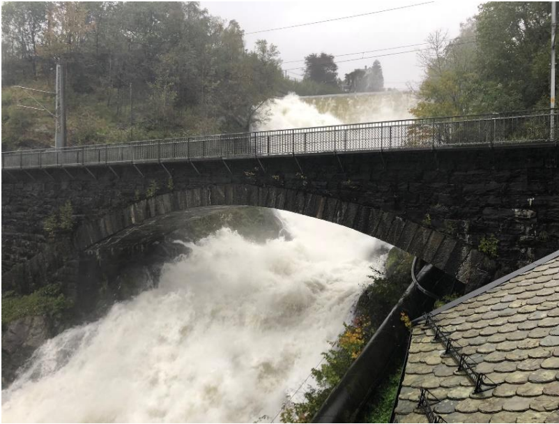
Bilde 6 Vannføring under jernbanebru rett nedstrøms dammen. God klaring til underkant hvelvbru og brulandkar (september 2018).
