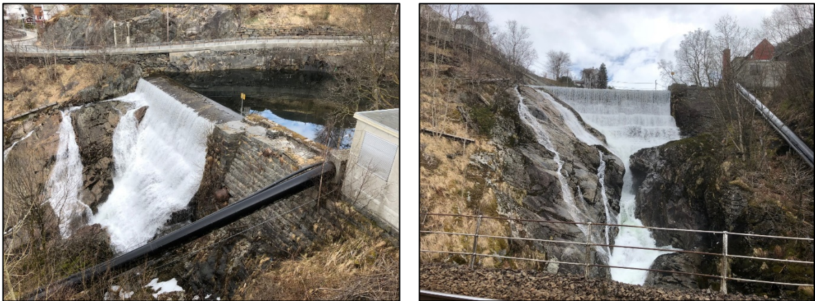
Figur 1. Dammen sett sørfra fra Trollkjelsvegen (t.v.). Dammen sett fra Bergensbanen (t.h.). Foto: Småkraft AS.
