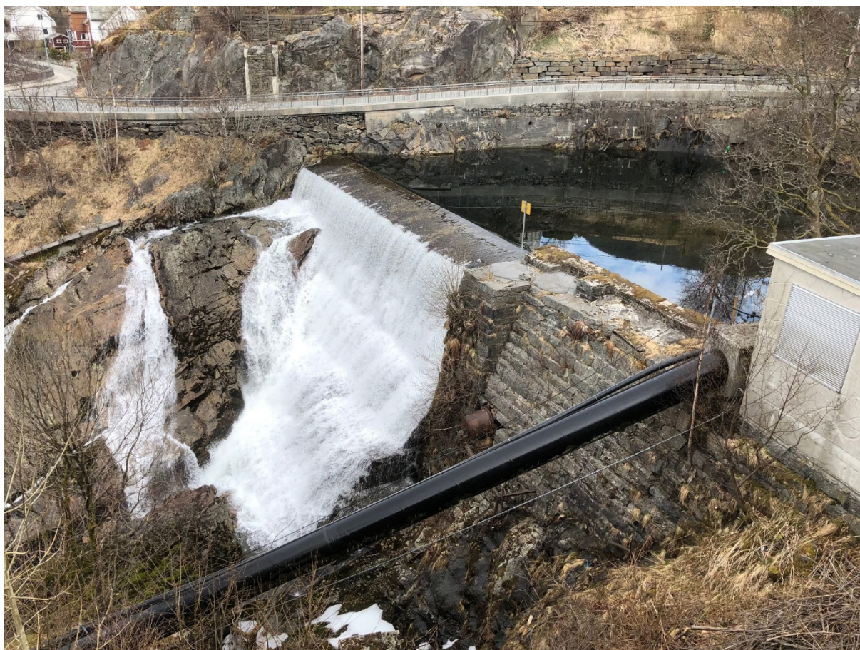
Fig. 5: Dammen sett sørfra fra Trollkjelsvegen. Foto: Småkraft AS
