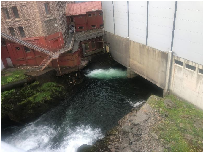
Bilde 3 Innløp til flomkanal under Vaksdal Mølle, ved lav vannføring.
