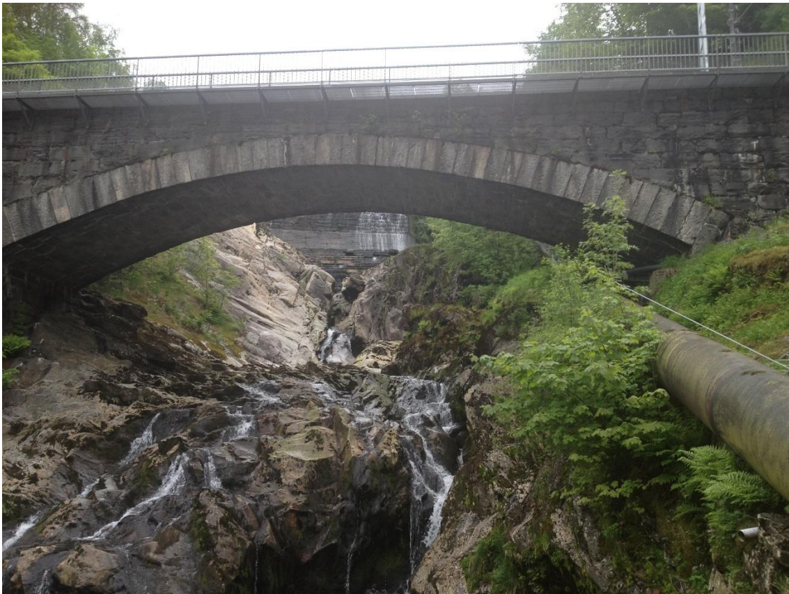
Bilde 2 Jernbanebru nedstrøms dam Trollkjelen (kan ses ca. 50 m oppstrøms)
