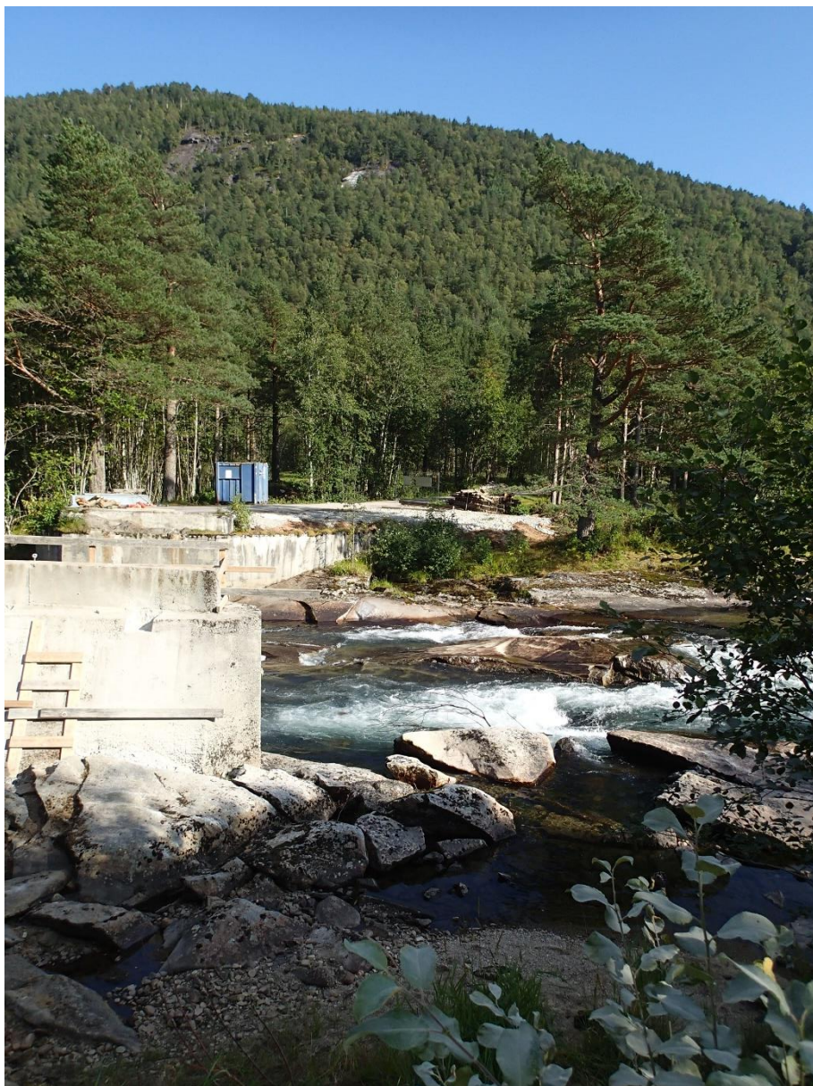
Figur 2-4: Bilde fra like oppstrøms topp fossefall. På bildet ser vi brofundamentet til broen som krysser Smisetfossen like nedstrøms planlagt inntaksdam. Broen var tatt bort denne dagen.
