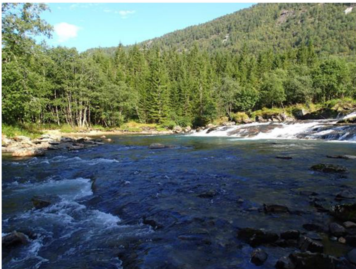
Figur 3: Bilde tatt fra vestsiden og rett inn mot kraftstasjonsområdet.
