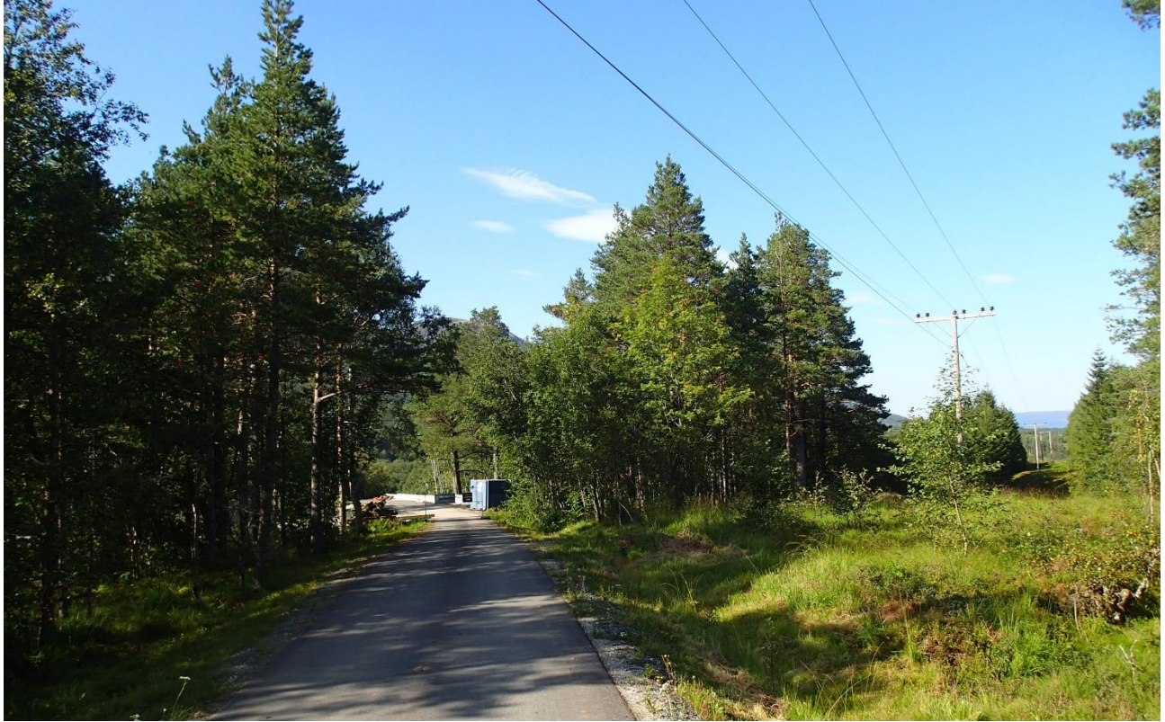
Figur 4-2 Det går ei kraftlinje på østsiden av elva. Brua over Smisetfossen ligger i enden av veien på bildet.
