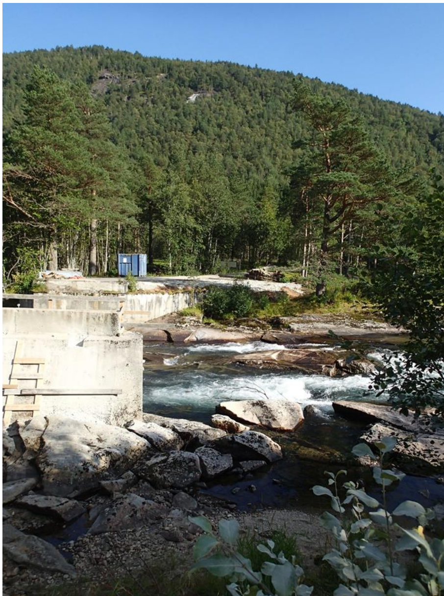
Figur 4: Bilde fra like oppstrøms topp fossefall. På bildet ser vi brofundamentet til broen som krysser Smisetfossen like nedstrøms planlagt inntaksdam. Broen var tatt bort denne dagen.
