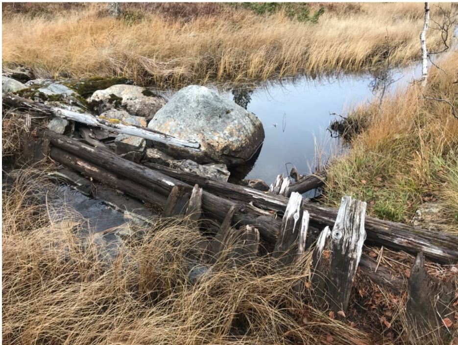
Figur 8. Demninga ved Ulvtjønna er i dag ødelagt og vannstanden er trolig nær den naturlige.
