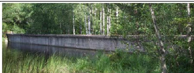
Bilde 2 Sekundærdam Rødvann sett fra oppstrøms høyre side
