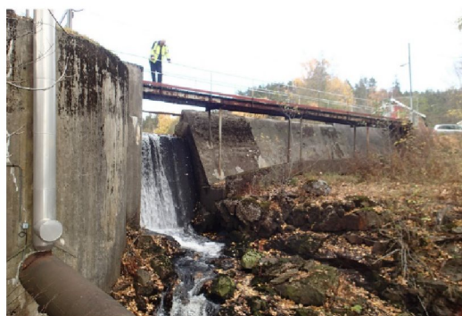
Bilde 8 Engdammen sett fra nedstrøms høyre side
