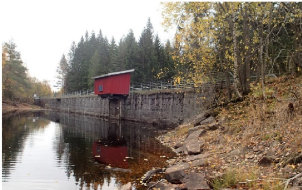
Bilde 5 Dam Røskestadvann sett fra oppstrøms høyre side
