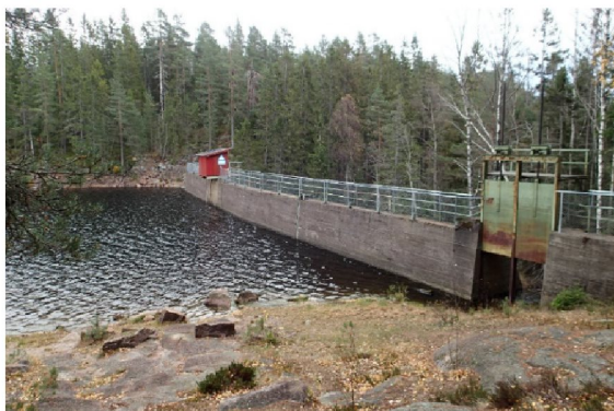
Bilde 3 Dam Langvann sett fra oppstrøms side
