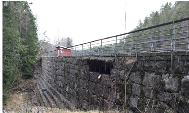
Bilde 6 Dam Røskestadvann sett fra nedstrøms venstre side
