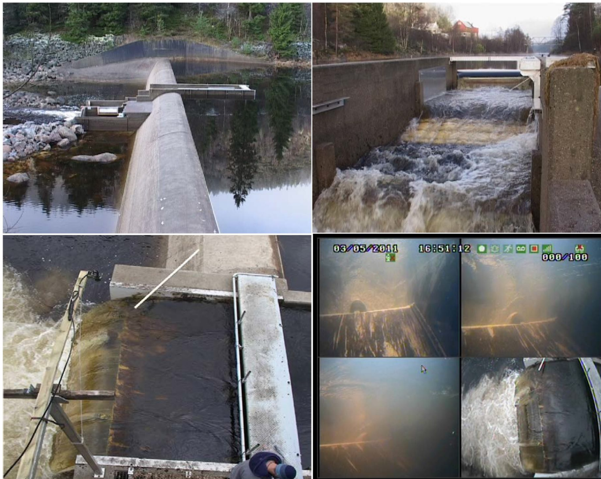
Figur 4.1. Fisketrappa i midten av dammen i utløpet av i Manflåvann i Mandalsvassdraget i 2011 (de to øverste bildene). I tillegg til tre undervannskamera, ble det også montert ett overflatekamera dette året (de nederste to bildene). Bilder fra disse fire kameraene dekker hele tverrsnittet av reguleringsluke i dammen.
