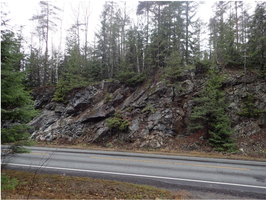
Figur 8: Skjæringen nord for innkjøringen til trafostasjonen, vestre del.
