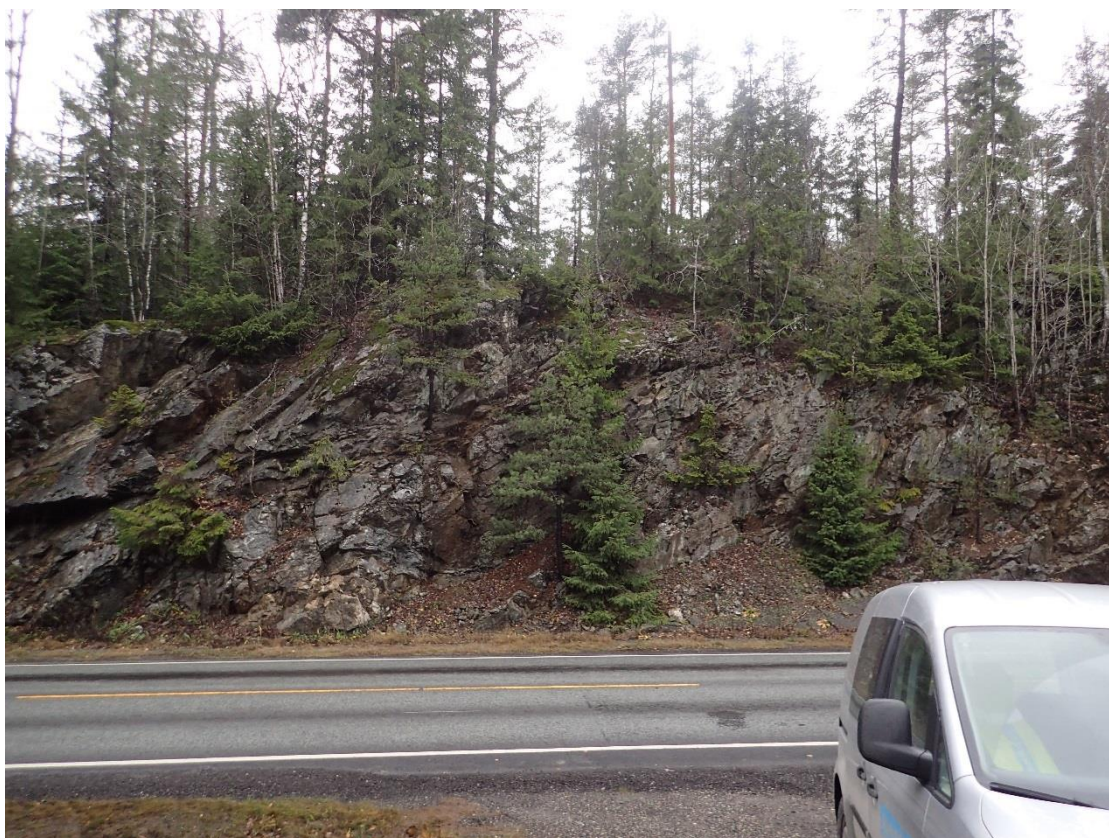
Figur 9: Skjæringen nord for innkjøringen til trafostasjonen, østre del.
