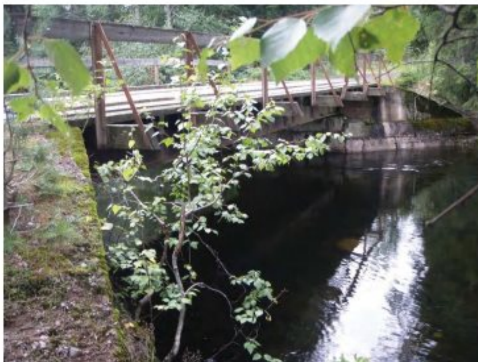
Figur 15 Bru nedstrøms Stryken
