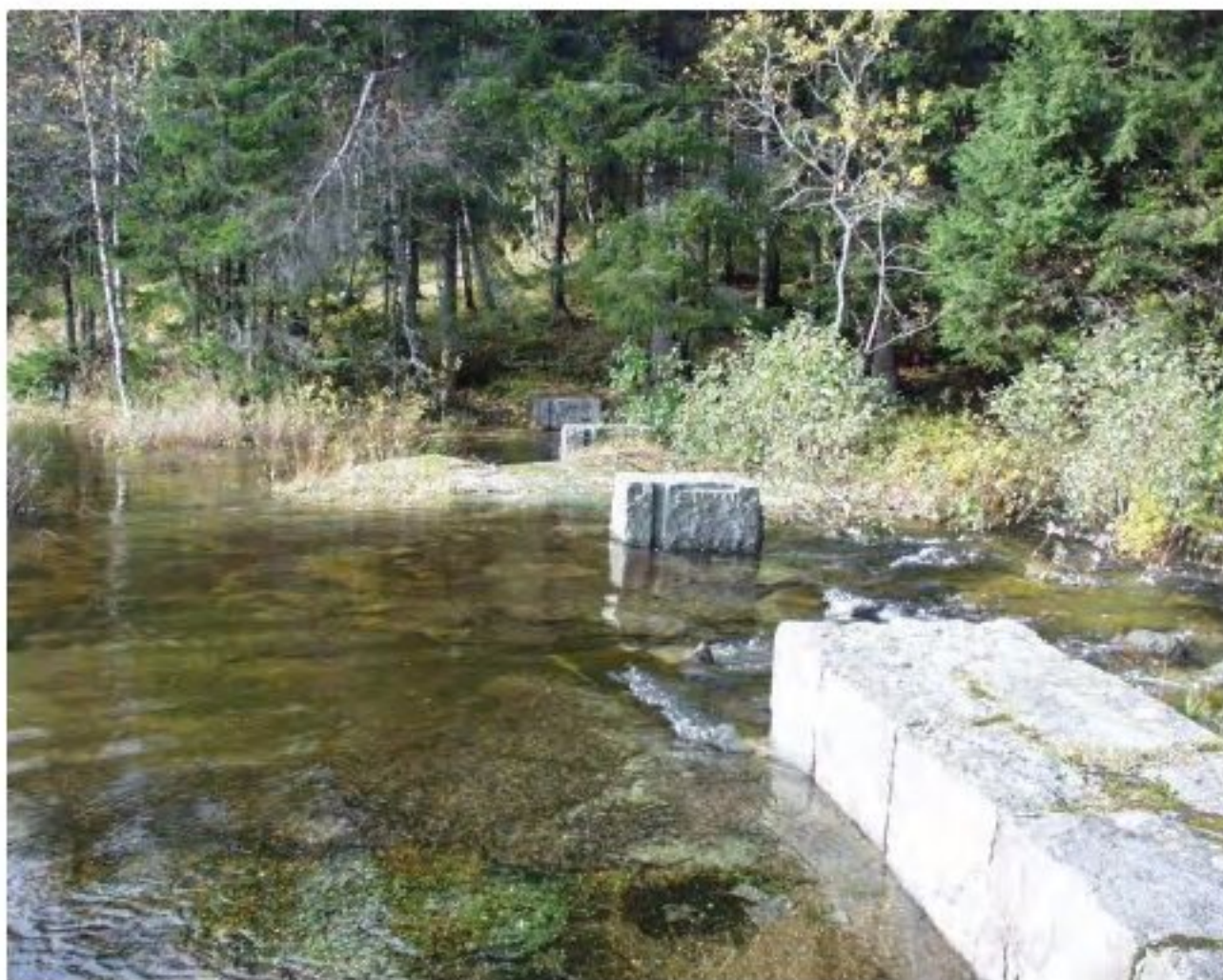
Figur 1 Overløpsterskel ved utløpet til Daltyven
