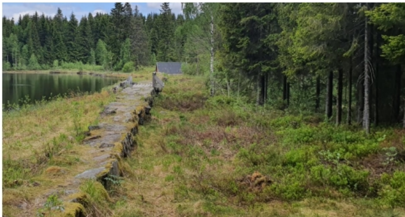
Figur 4: Dam Rottungen sett fra sør. Vegetasjonen bærer ikke preg av at det er vesentlige lekkasjer i dette området og blåbærdom i nerrefeltsjiktet i granplantefeltet.
