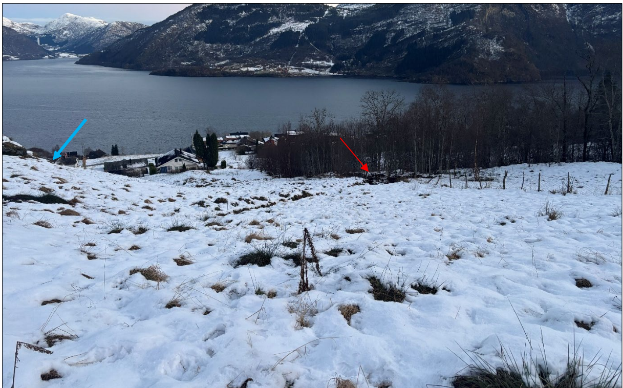
Figur 23: Dreneringsvegen som kjem ned i midtre del av påverknadsområdet (infopunkt 4) renn ut vest for gardstunet ved kartlagt område (raud pil). Reiskapshuset i kartlagt område ligg bak ryggforma til venstre i biletet (blå pil).
