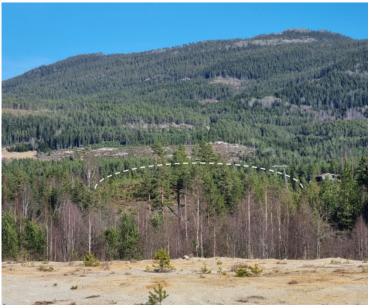
Figur 10: Sett østover i retning kolle der ny mast monteres, kan skimtes bak nærmeste vegetasjonsbelte (innzooming).
