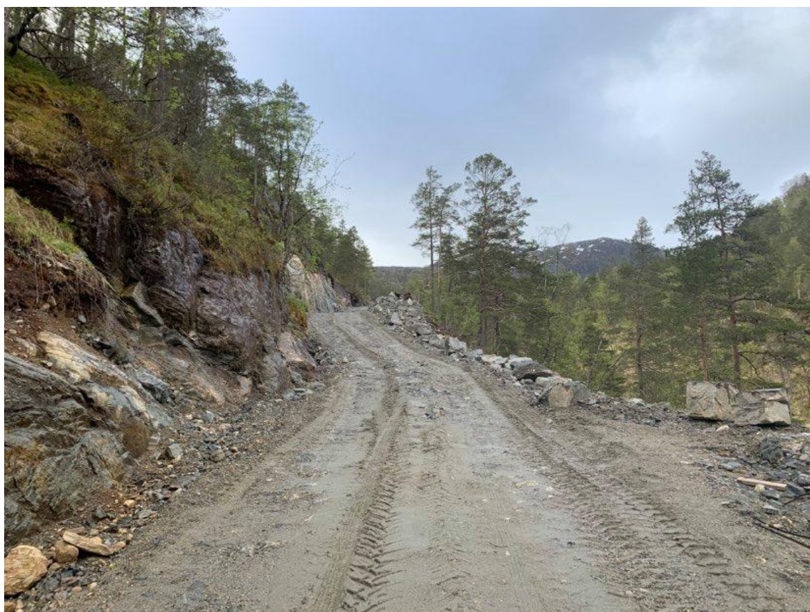
Bilde 4.2 Anleggsvei sett opp fra hjørnet
