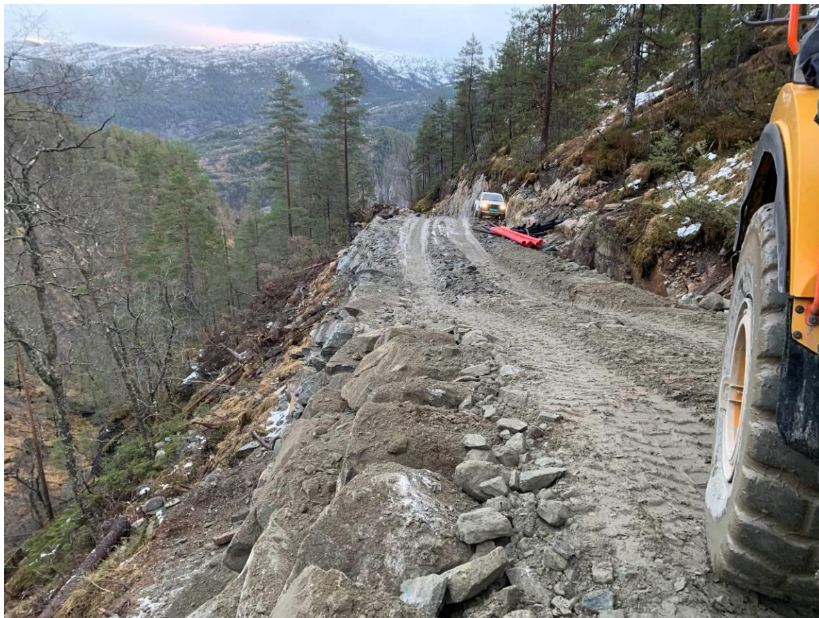
Bilde 4.3 Adkomstveien ned mot hjørnet
