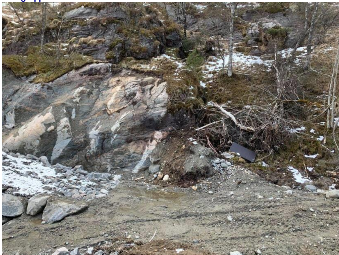
Bilde 3.1 Påhugg tunnel
