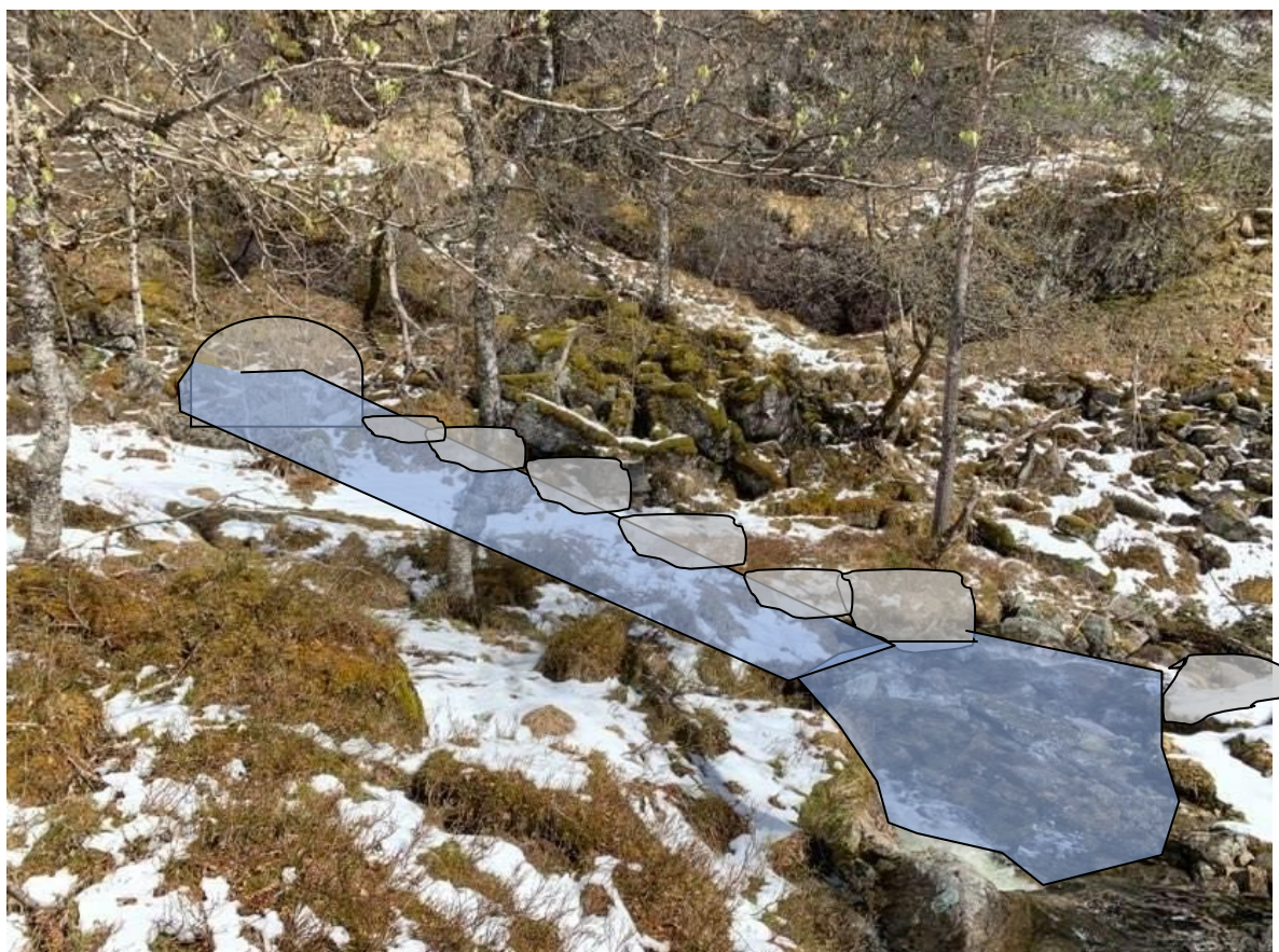
Bilde 2.2 Dam i elva med liten kanal bort til tunnelutslag
