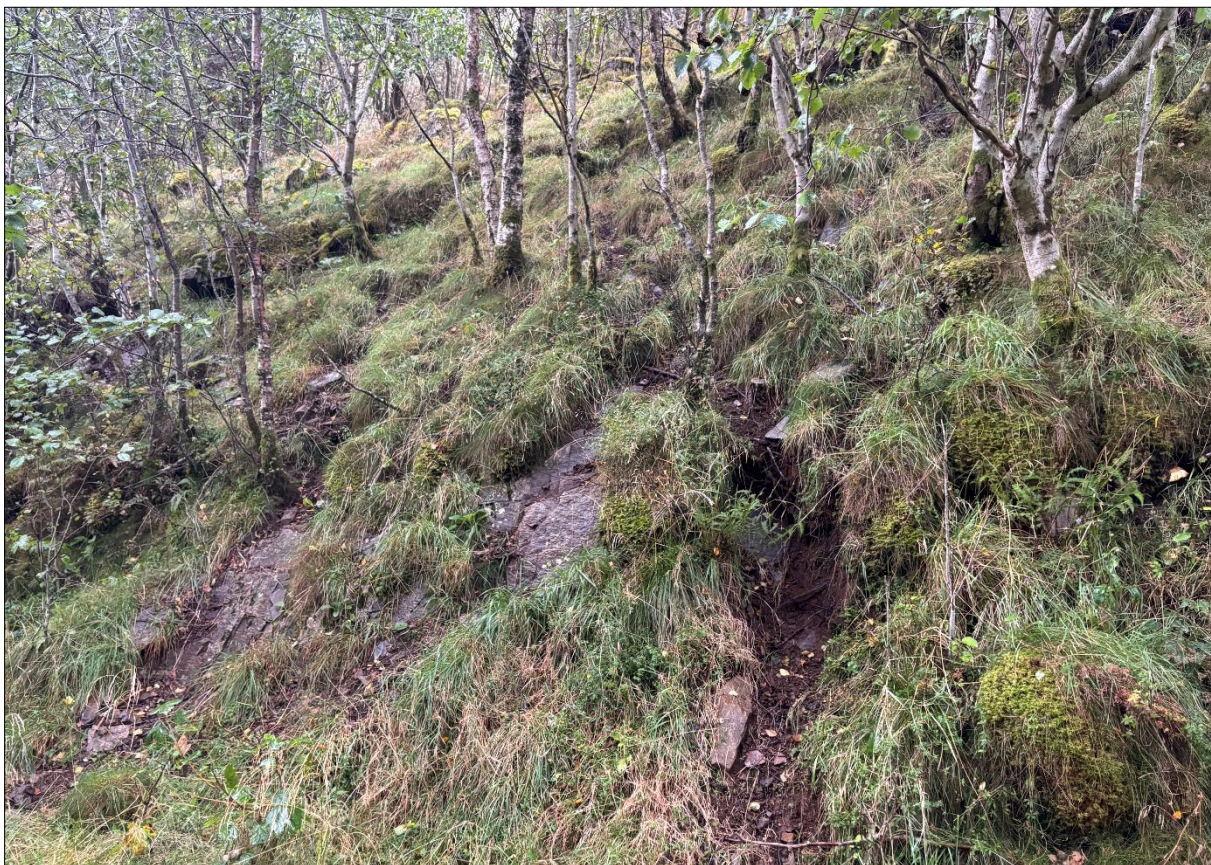
Figur 13: Tynt organisk materiale over fjell. Liten utglidning av løsmasser her, med en uløpslengde på ca. 2 m, og stopper i flatt terreng. Infopunkt 4.
