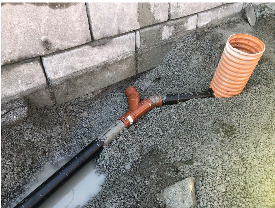
Figur 5. Nytt sandfang foran støttemuren ved barnehagen, bilde fra befaring 04-02-2020.
