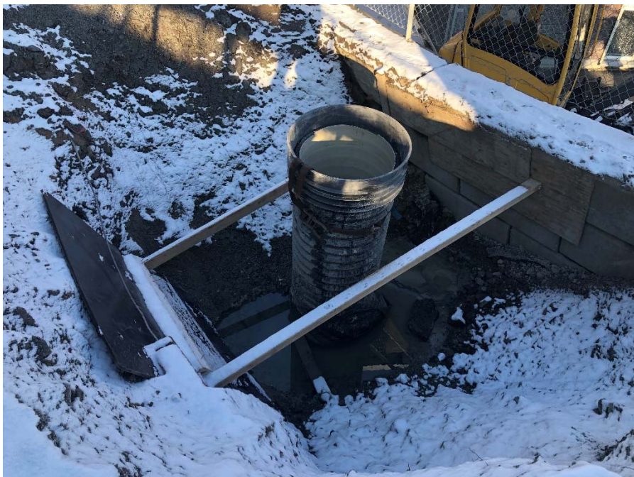
Figur 6. Eksisterende kum bak støttemuren, bilde fra befaring 04-02-2020.
