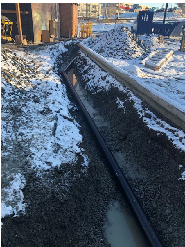
Figur 7. Etablering av drennende grøft og nytt tett rør med tilkobling til kum ved parkeringsplassen for barnehagen, bilde befaring 04-02-2020.
