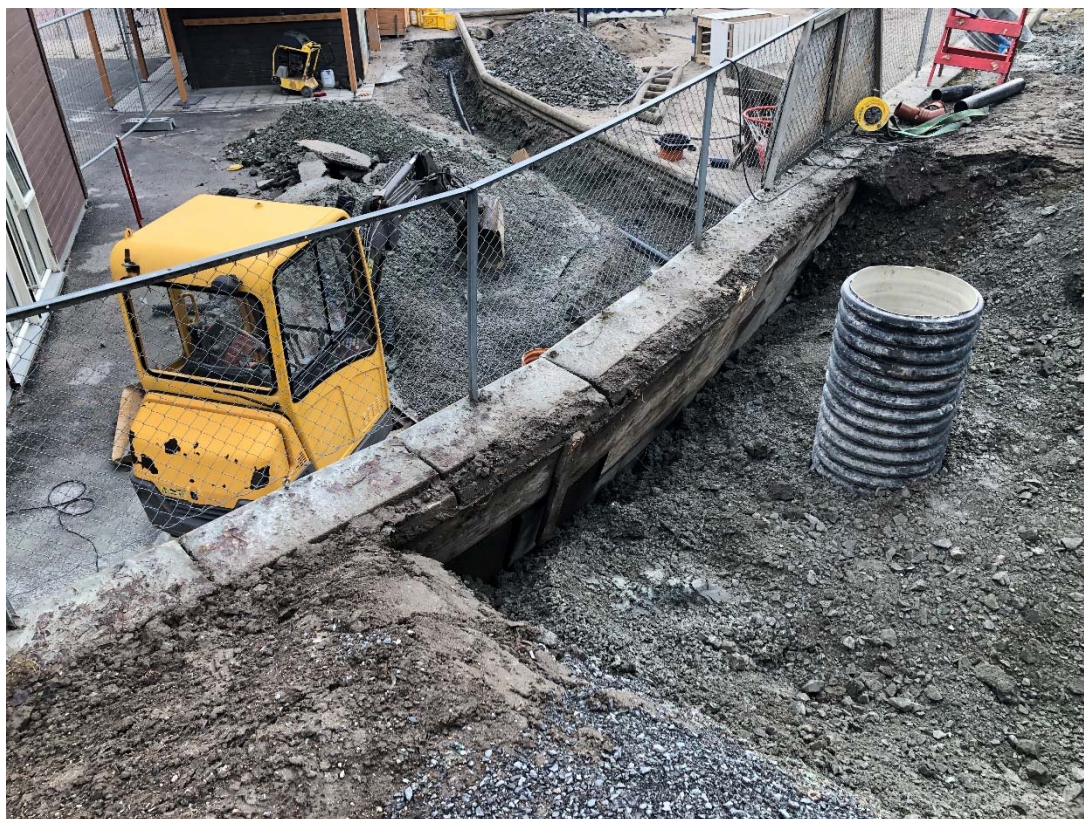
Figur 8. Bilde fra befaring den 10-02-2020.
