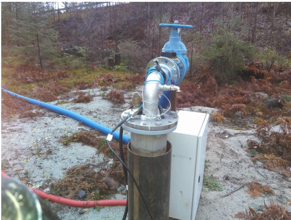
Figur 6-5: Bilde av brønntopp B4.
