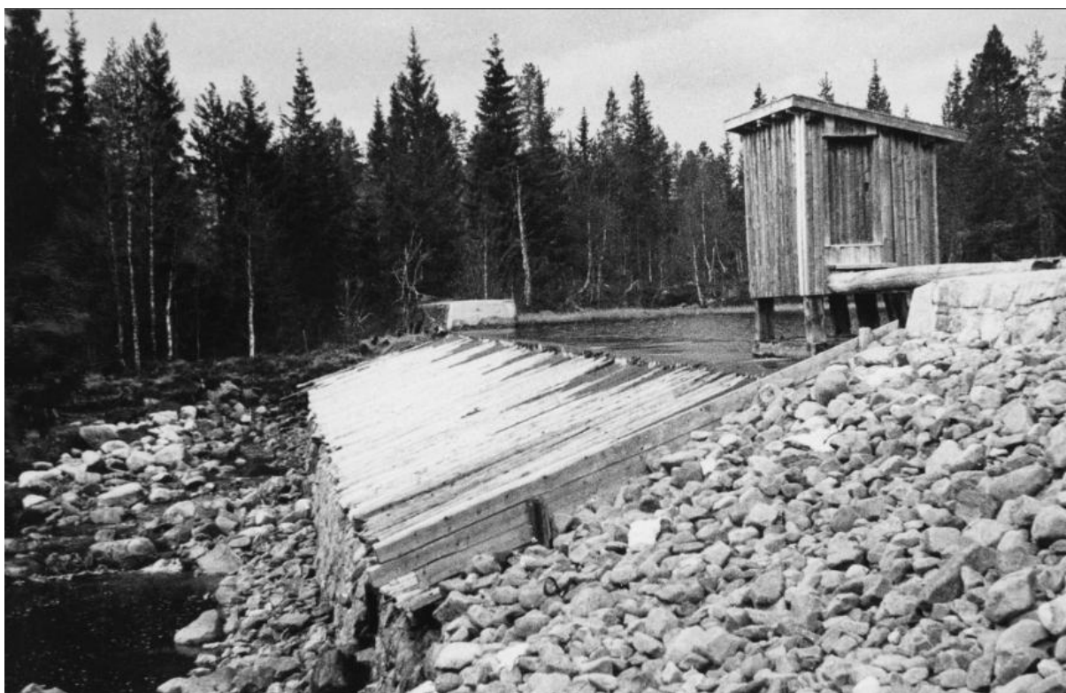
Bilde 2. Foto av Nybusjø-dammen fra 1944. Kilde: Anno Norsk skogmuseum (2014).
