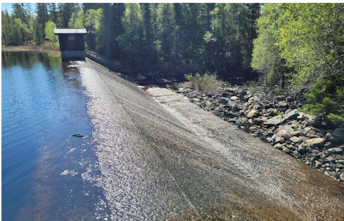
Bilde 3. Del av Nybusjø-dammen sett mot sørøst, 5.6.2023. Vannivået var da på HRV, og rant over damkrona.
