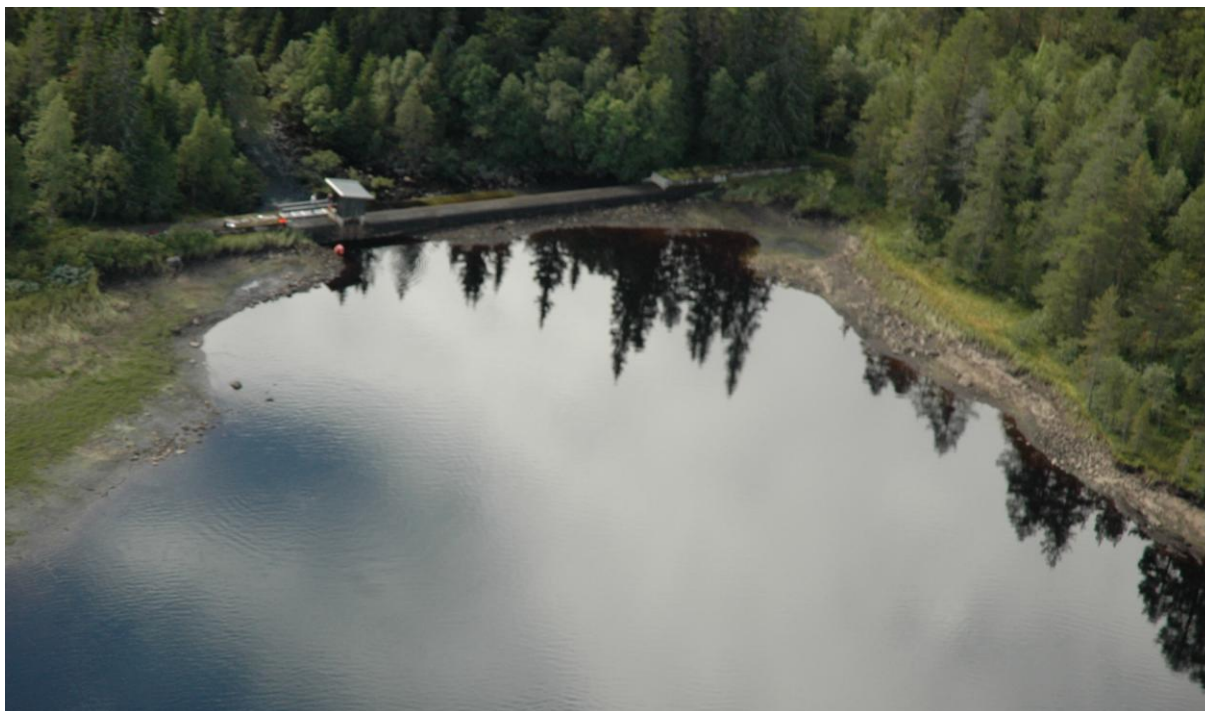
Bilde 1. Flyfoto av senkningen i 2012, med Nybusjø-dammen øverst i bildet. Da bildet ble tatt var vannoverflaten ca. 1,5 m lavere enn gjeldende HRV. Foto: Hamar kommune.
