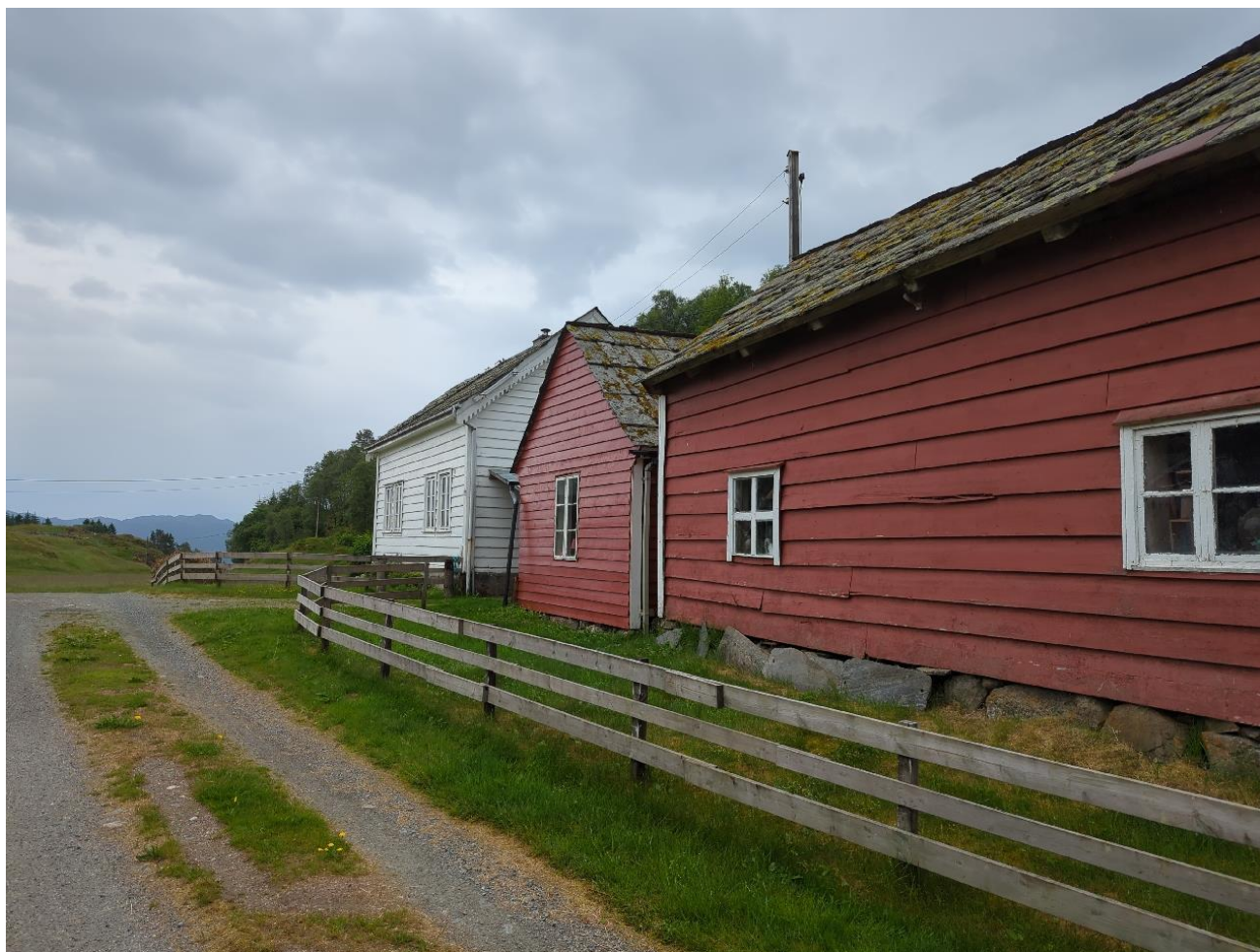
Figur 5-10. Eldre gårdsbygninger ved Øvre Kleppa (delområde B).
