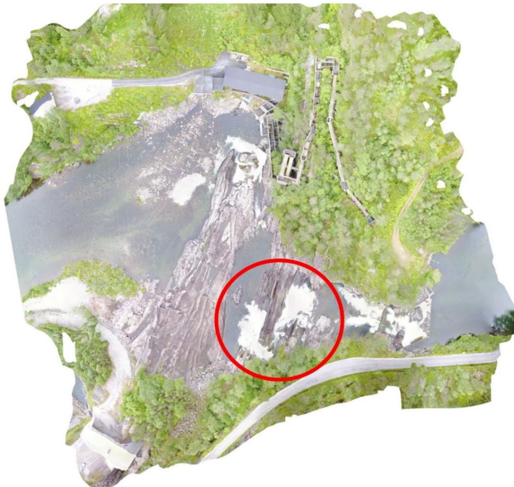
Figur 2-1. Hellandsfossen. Fosseparti med antatt størst sannsynlighet for skade på fisk er markert med rød sirkel.
