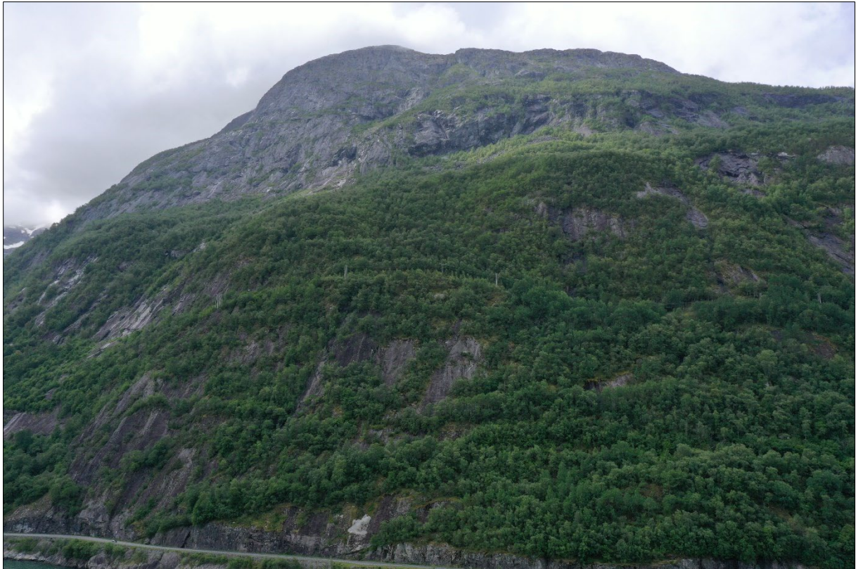
Figur 7: Dronebilde som viser fjellsida opp mot Sutenuten. Ny luftleidning er planlagt langs eksisterende trasé i fjellsida, og mastepunkt 39 – 42 er omtrent midt i bildet som er tatt mot søraust.
