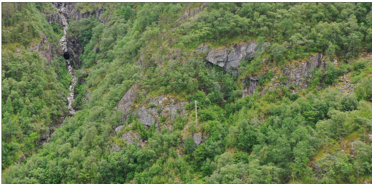
Figur 37: M77 var tenkt plassert ved eksisterande mast midt i bildet. Skredfare er vurdert som lågare enn 1/150 her, men mastepunkt er flytta for å unngå fundamentering på potensielt ustabil blokk.
