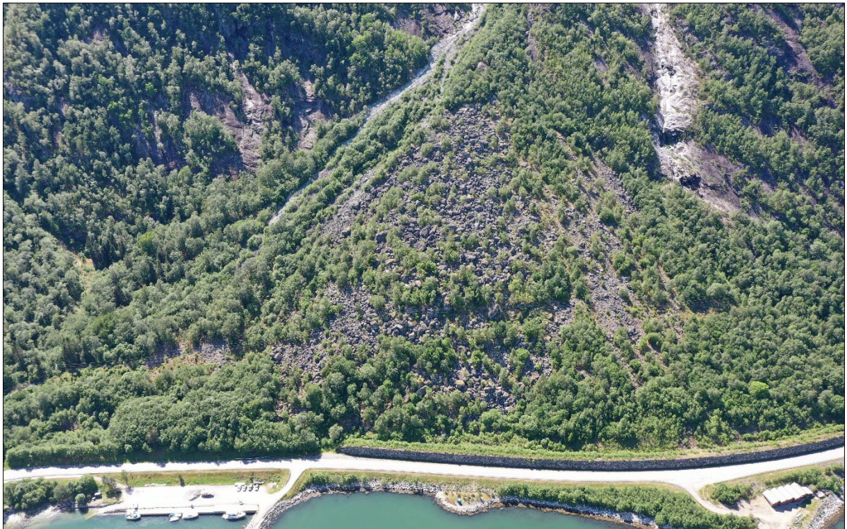
Figur 35: Storura som går ned mellom Gamlenausta og Menes. Snøskredløp ned vifta. Infopunkt 18.
