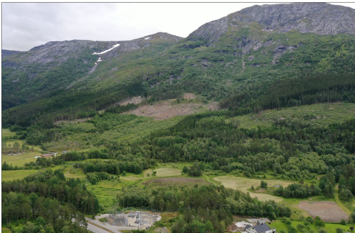
Figur 24: Dronebilde av transformatorstasjon på Bu og fjellsida ovanfor.
