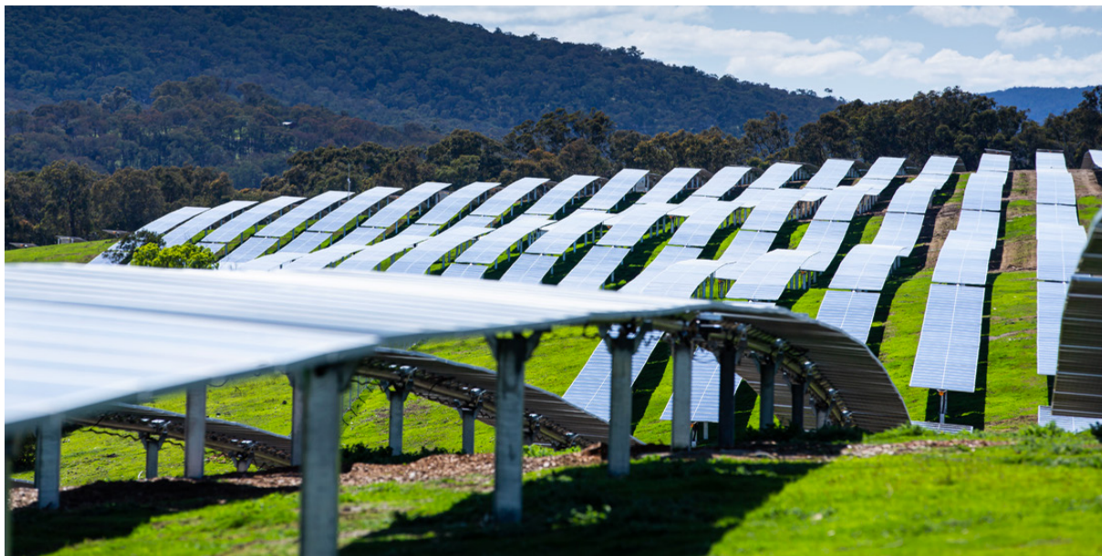
Figur 8 Illustrasjonsfoto én-akse systemet NX-Horizon -XTR levert av selskapet Nextracker. Foto fra Nextracker.
