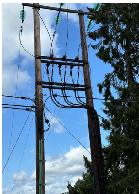
Figur 13 Illustrasjon - mastehengt koblingsanlegg 22 kV
