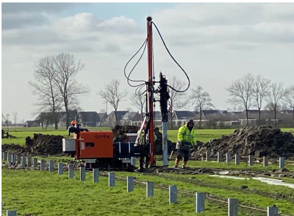
Figur 9 Eksempel på pælemaskin for fundamenter fra konstruksjonen av Energeias solkraftverk i Nederland.
