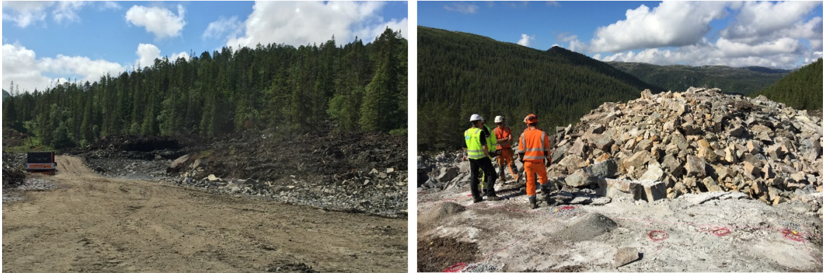
Figur 17 Anleggsarbeider ved nydyrking, massehåndtering og sortering av forskjellige steinstørrelse. Kilde: Multiconsult.
