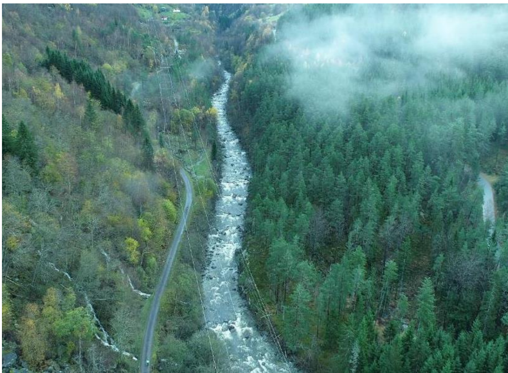
Figur 4-26. Strykstrekning mellom bru Gardavegen (samløp Bleskestadåa og Nordmorkåa) og foreslått kraftverksutløp ved Nordmork. Foto er tatt på flomvannføring med overløp fra Kvanndalsmagasinet. Partiet går i dag periodevis tilnærmet tørt.
