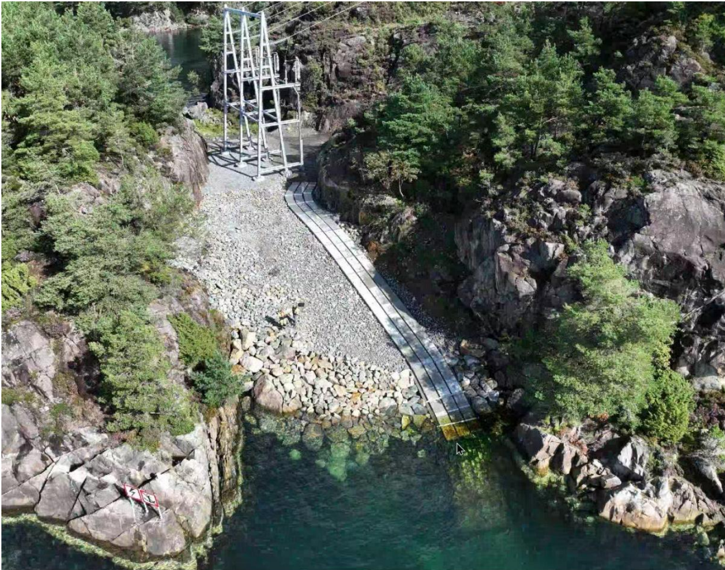
Figur 2-11 Eksempel på beskyttelse av kabelen med betongelementer. Bildet viser at beskyttelsen går helt opp til kabelendemast. Dette vil være tilfellet for Reksteren/Tysnes, for Otteråi/Austevoll vil kabelen kun beskyttes i skvalpesonen, det vil si ca. 7 meter fra sjø og oppover på land. For begge landfallene vil det bli lagt betongelementer noen meter ned i sjø som kabelbeskyttelse i skvalpesonen (tar høyde for lavvann og høyvann). Foto: Fagne.
