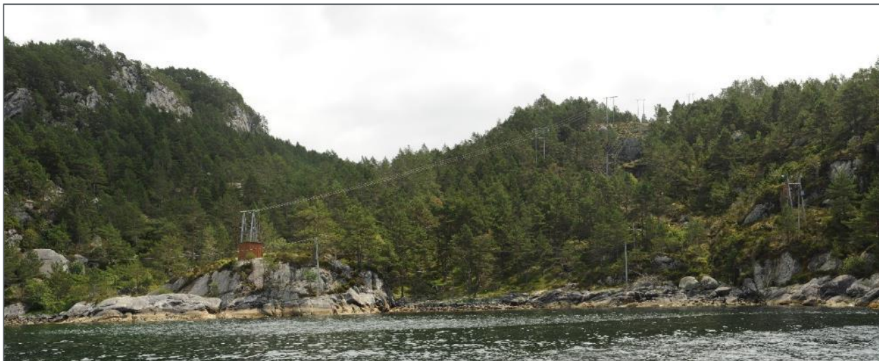
Figur 5-18. Eksisterende 66 kV-ledning følger et søkk i terrenget ned til Ersvika på Reksteren/Tysnes.
