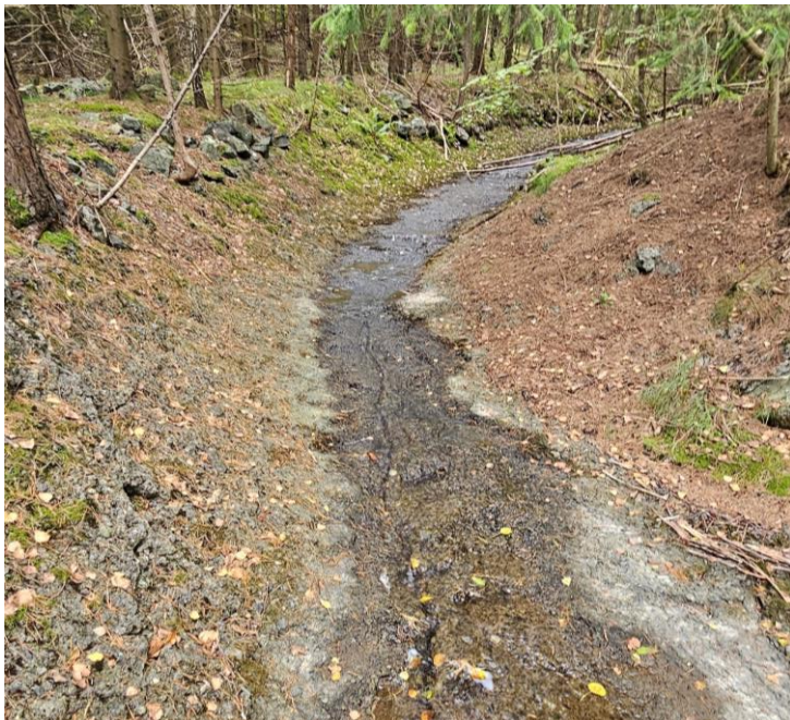
Figur 3-7 Betongplastret bekkeløp ca. 150meter langt.
