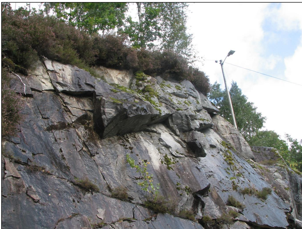
Figur 8. Eksempelbilde på bergtype og oppsprekking. Bilde er fra bergskrent langs veien i kartleggingsområdet. Bilde tatt av Multiconsult i forbindelse med skredfarevurdering i 2007 [5].
