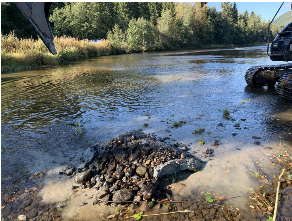
Figur 8-2: Rett oppstrøms Vollahølen var det leire rett under et tynt gruslag.
