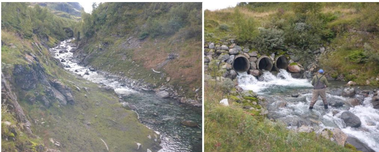
Figur 23. Tverrelva er den eneste befarte bekken som aure har mulighet til å vandre opp i fra Valldalsvatnet. Det ble ikke registrert fisk i bekken under elfiske høsten 2019. Det ble ikke registrert vandringshindre i bekken før kulvert der bekken krysser veien.
