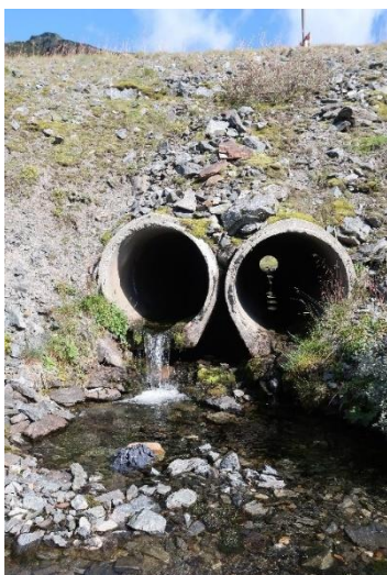
Figur 54. Ved «bekk 8» er det fiskestopp for det meste av/hele året ved kulvert under E134. Det ble påvist aure på hele strekningen fra Votna opp til kulverten.
