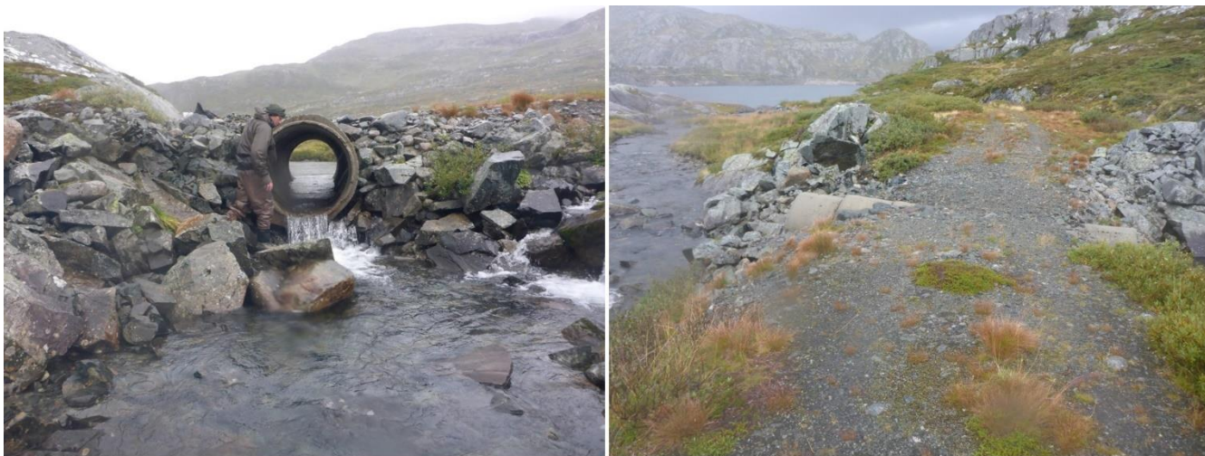
Figur 29. Kulvert under en eldre grusvei setter en effektiv stopper for oppvandrende aure. Utbedring/fjerning av kulvert vil gi gytefisk fra Sandvatnet tilgang til flere hundre meter bekkestrekning.
