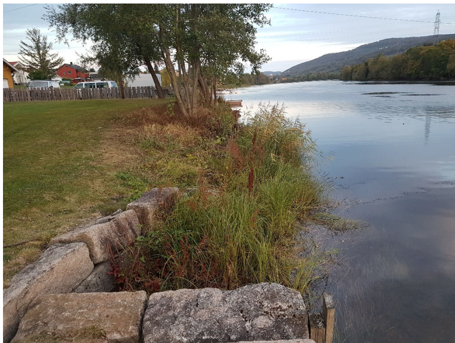
Figur 4. Bilde B3 fra befarig 22.09.2021.
